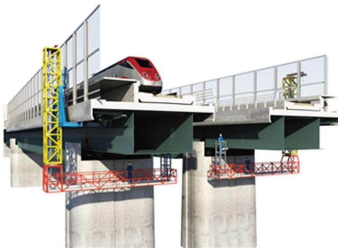
**Figura 1-2. Carrelli mobili di ispezione impalcati**
