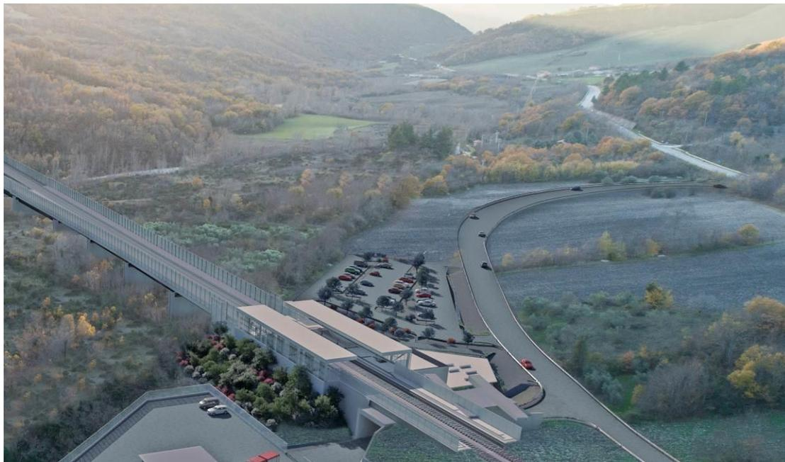
Figura 5-10. Fotoinserimento su vista a volo d'uccello della stazione e della modellazione morfologica del rilevato prevista in Progetto Esecutivo.
