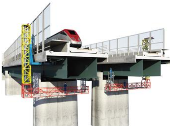
Figura 3-6. Carrelli mobili di ispezione impalcato
