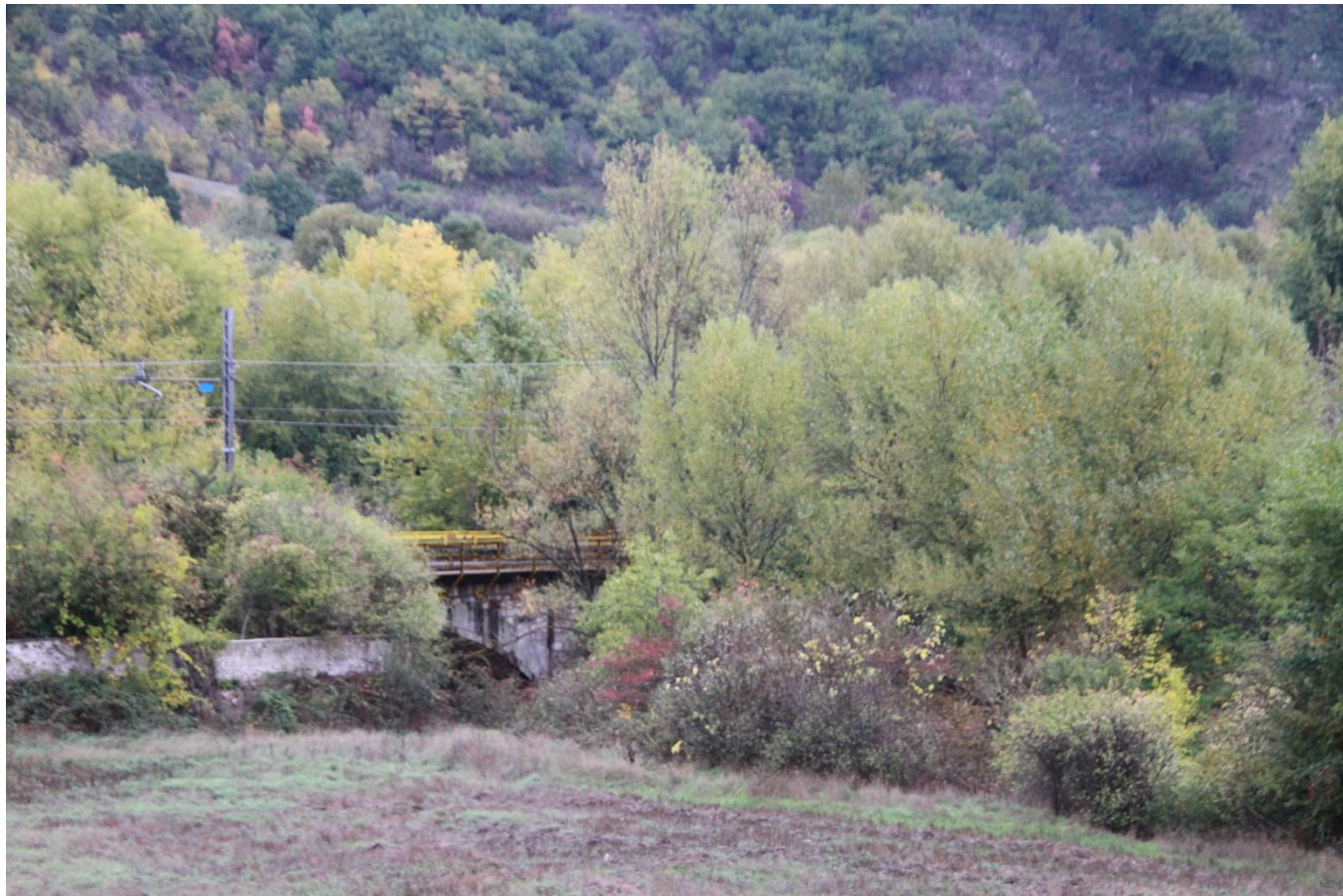
Foto 10. Scorcio del ponte sul Cervaro del preesistente tracciato ferroviario nei pressi dell'area di cantiere dell'area N del progetto.
