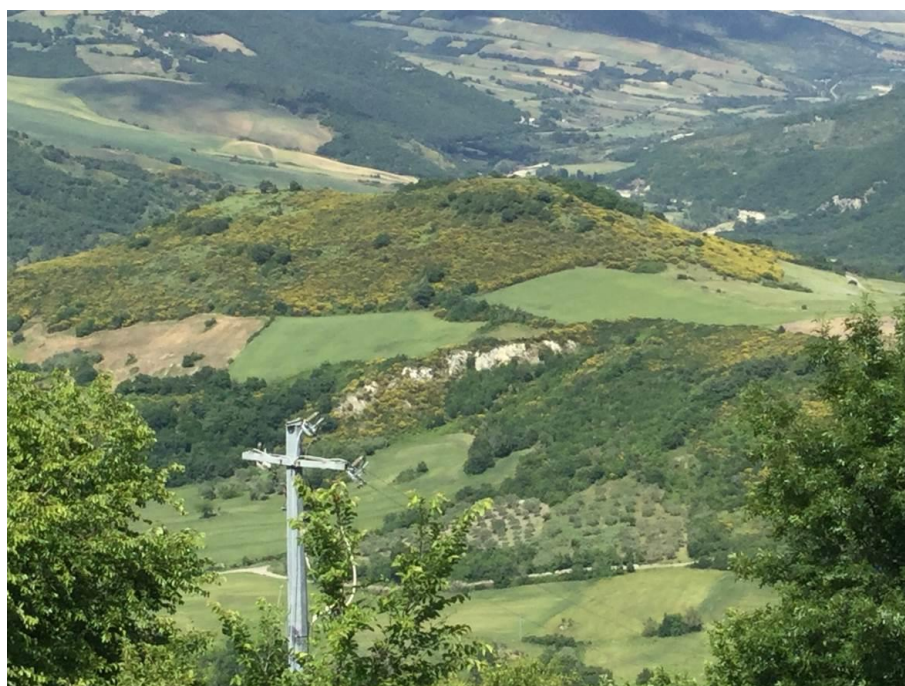
Figura 2-5. Vista dei movimenti franosi che interessano l'impluvio a NE di Panni, a monte dell'imbocco nord-orientale della galleria "Hirpinia"
