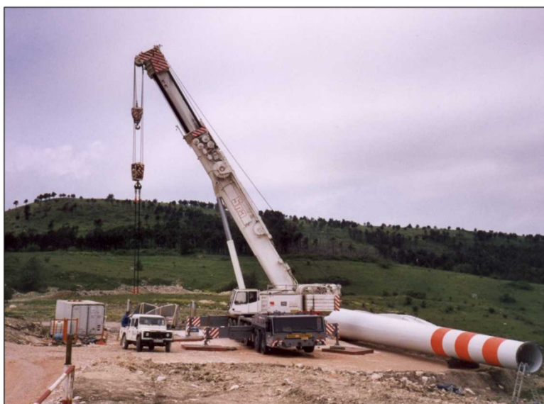
Figura 1.4.6.-1.: Fase di montaggio di un aerogeneratore.
