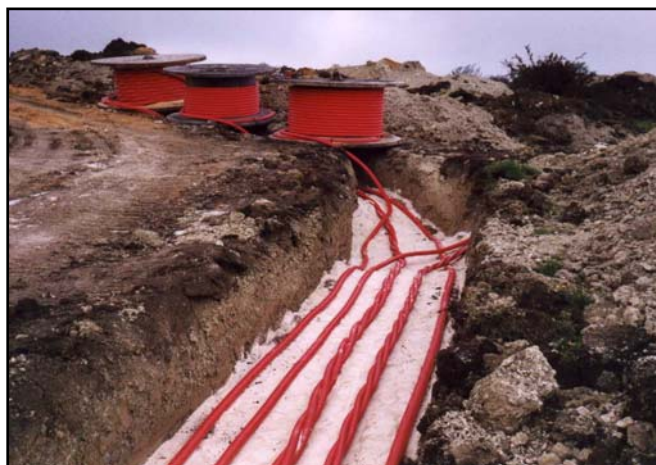
Figura 1.4.7.-1.: Particolare della posa cavi elettrici.
