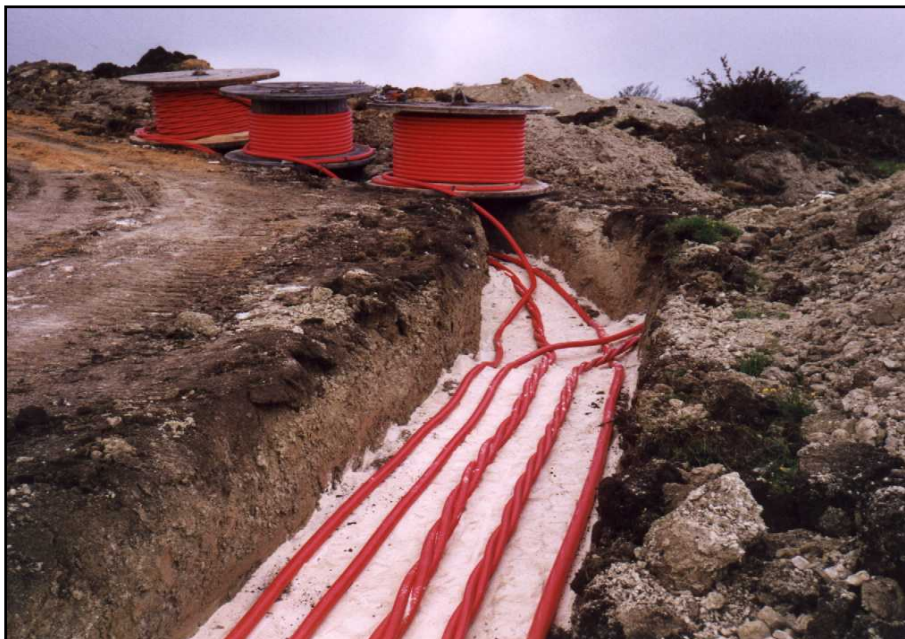
Figura 1.4.7.-1.: Particolare della posa cavi elettrici.
