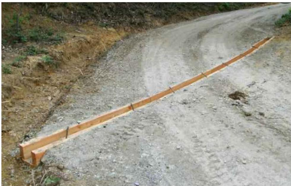
Figura 10-7 – Opere di regimentazione idraulica – rompiflusso in legno
