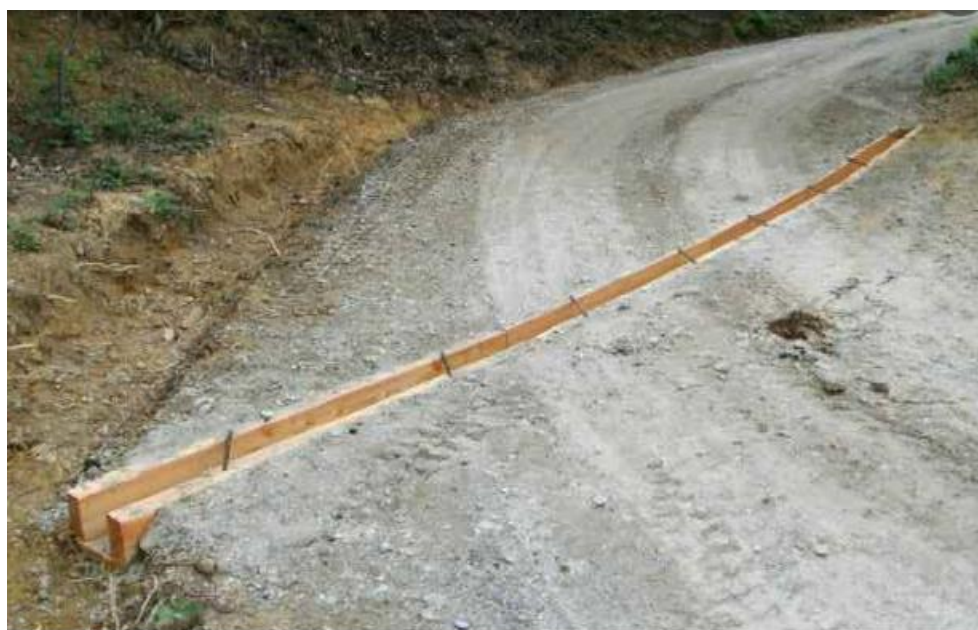
Figura 7-7 – Opere di regimentazione idraulica – rompiflusso in legno
