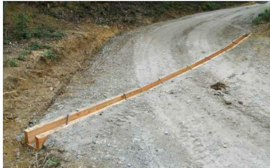
Pianta tipico canaletta in legno - viabilità di progetto con pendenza superiore al 10% - Scala 1:50
