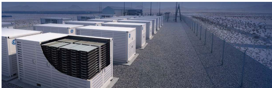
Figura 11 tipologico unità di accumulo
