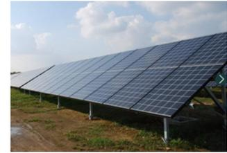
Le vele sono composte esclusivamente da parti fisse, e sono ancorate al terreno mediante infissione di pali verticali (o altre soluzioni staticamente valide e adeguate al contesto e al terreno in cui dovranno essere ubicate); su di esse sono posizionati i pannelli fotovoltaici.
