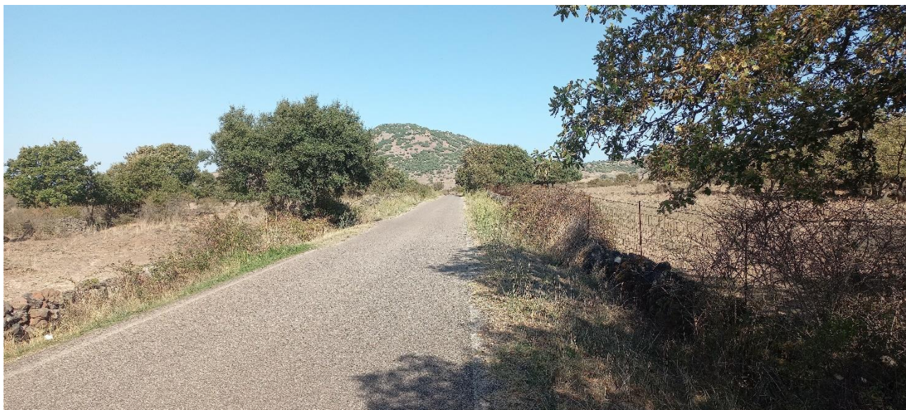
IMG 35. PUNTO FOTO 33. PERCORSO CAVIDOTTO. BONORVA.
