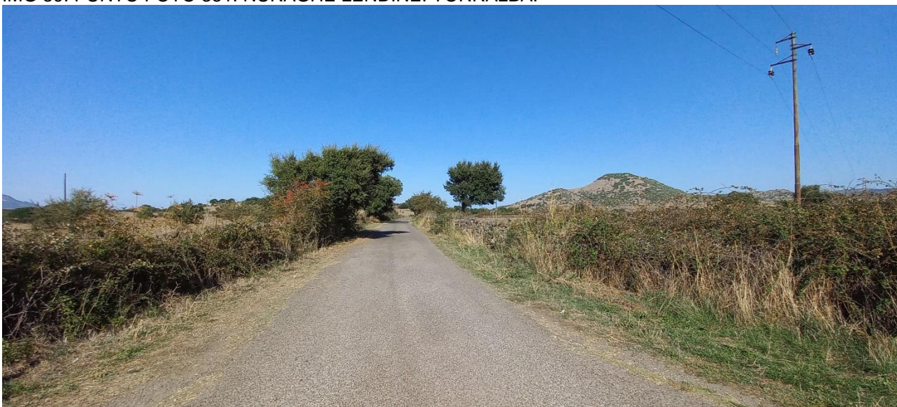
IMG 40. PUNTO FOTO 36. PERCORSO CAVIDOTTO. TORRALBA.
