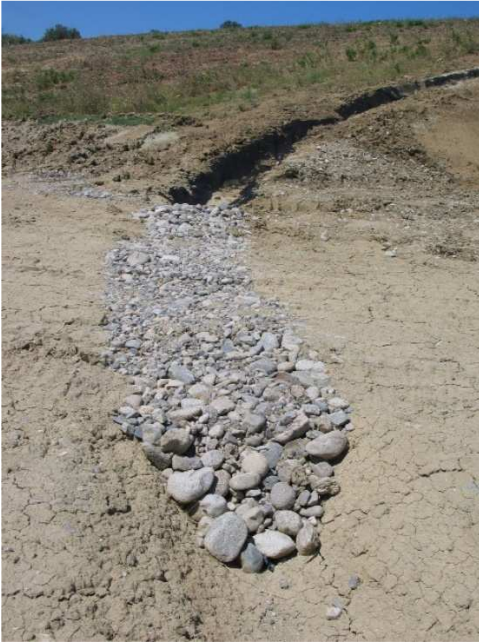
Tipico del drenaggio delle acque superficiali
