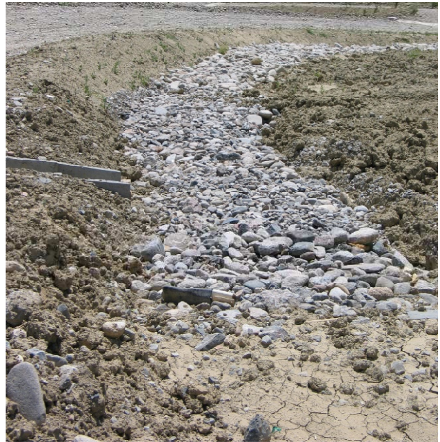
Tipico del drenaggio delle acque superficiali
