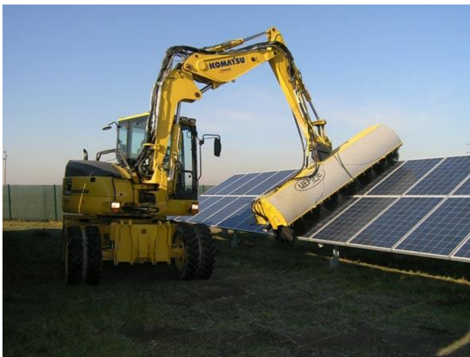
Figura 12 - Lavaggio moduli fotovoltaici
