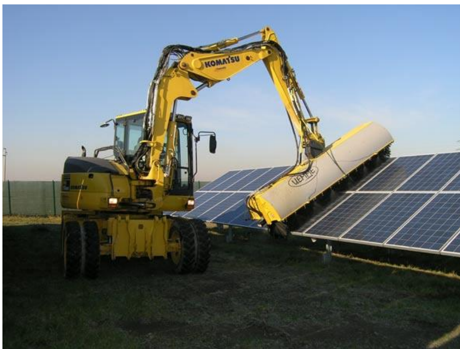
Figura 10 - Lavaggio moduli fotovoltaici
