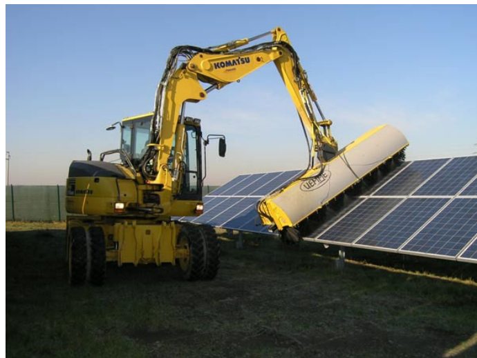
Figura 9 - Lavaggio moduli fotovoltaici
