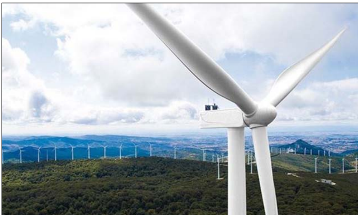
Figura 3 – Esempio di installazione di turbina eolica
