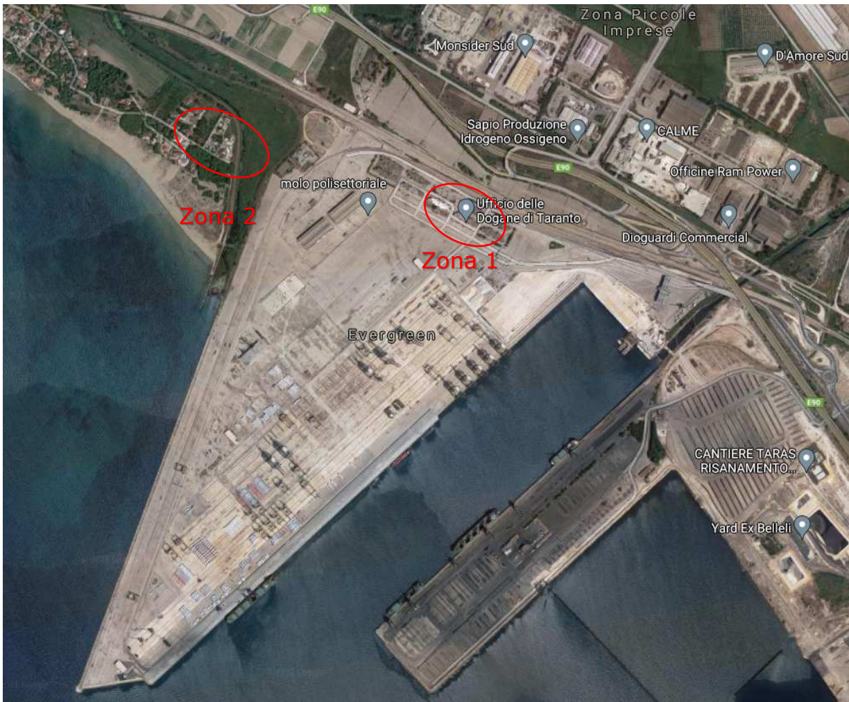
Vista aerea zone di monitoraggio
