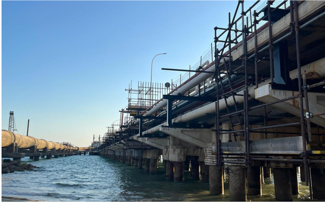
Figura 3-2 –Pali esistenti del Pontile RAGE
