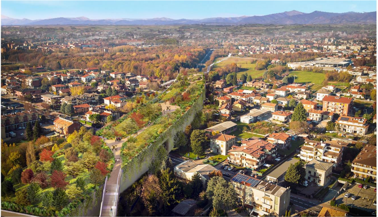
Figura 5 – La nuova copertura della galleria di Seveso
