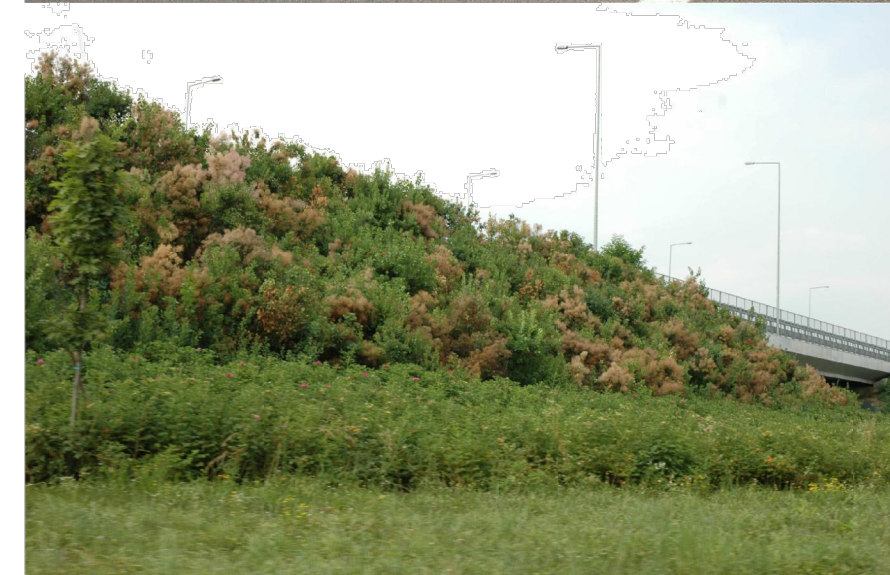
Particolari impianto specie ornamentali su scarpata
