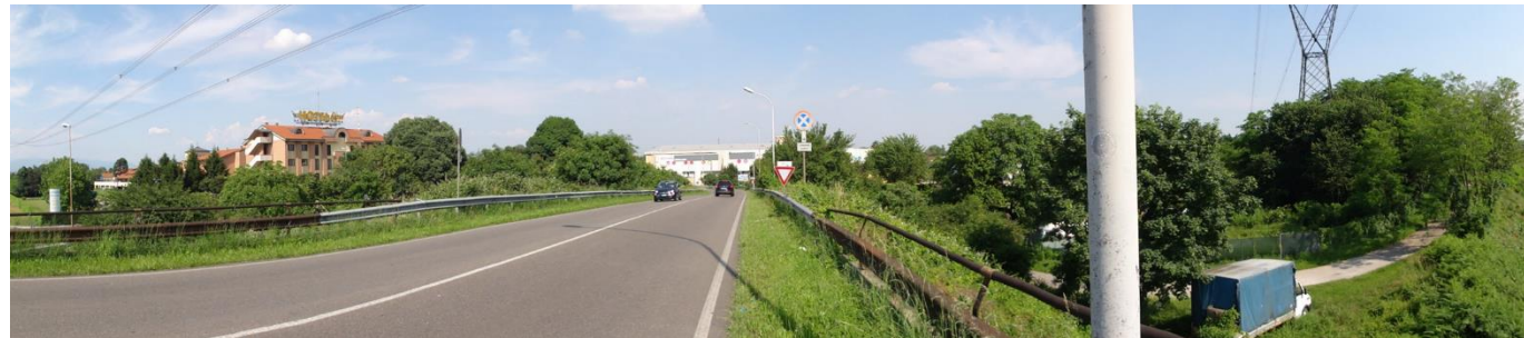
Foto da cavalcavia Via Col di Tenda ( Cesano Maderno) di scavalco della SP 35
