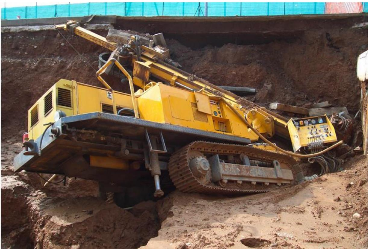
*Figura 18 – OP nei depositi alluvionali; cavità nei depositi sciolti di dimensioni ragguardevoli; si notano canali di interconnessione tra le diverse cavità, aventi forma lineare e non ellittica come le cavità principali. (fonte: dott. Fabio Baio)*
