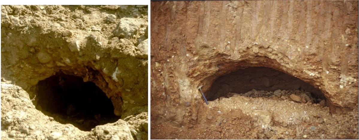
*Figura 15 - Esempio di cavità rinvenuta durante gli scavi in un cantiere presso Novedrate, a sx; a dx sezione di un occhio pollino presso Bernareggio formatosi in ghiaie alterate; si notano alcune caratteristiche tipiche quali la volta emisferica e il materiale di crollo alla base (fonte: dott.Andrea Strini)*
