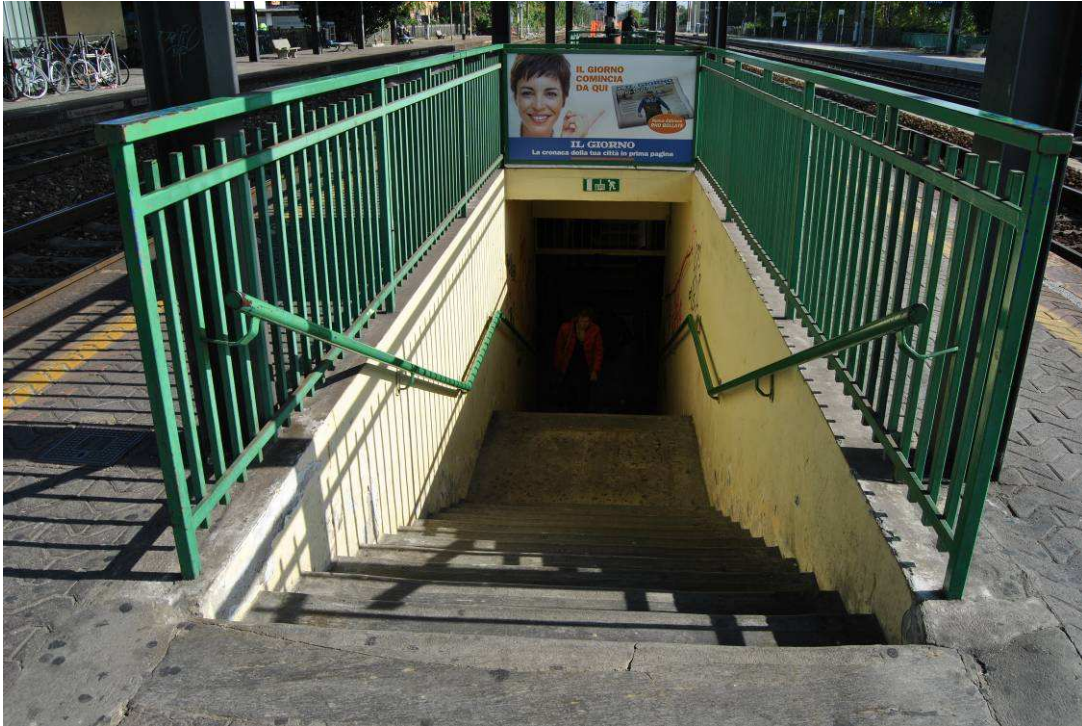
Scala di accesso al sottopasso - foto stato attuale
