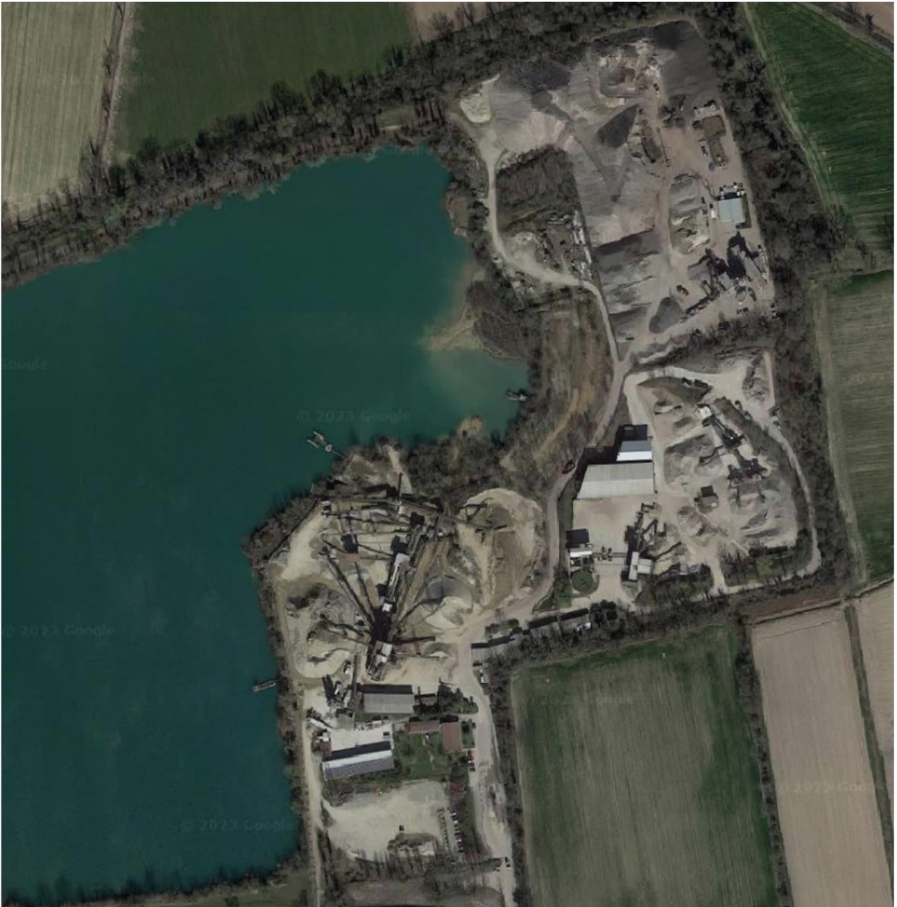
Figura 6-22 – Ortofoto dell'impianto di Peschiera Borromeo
