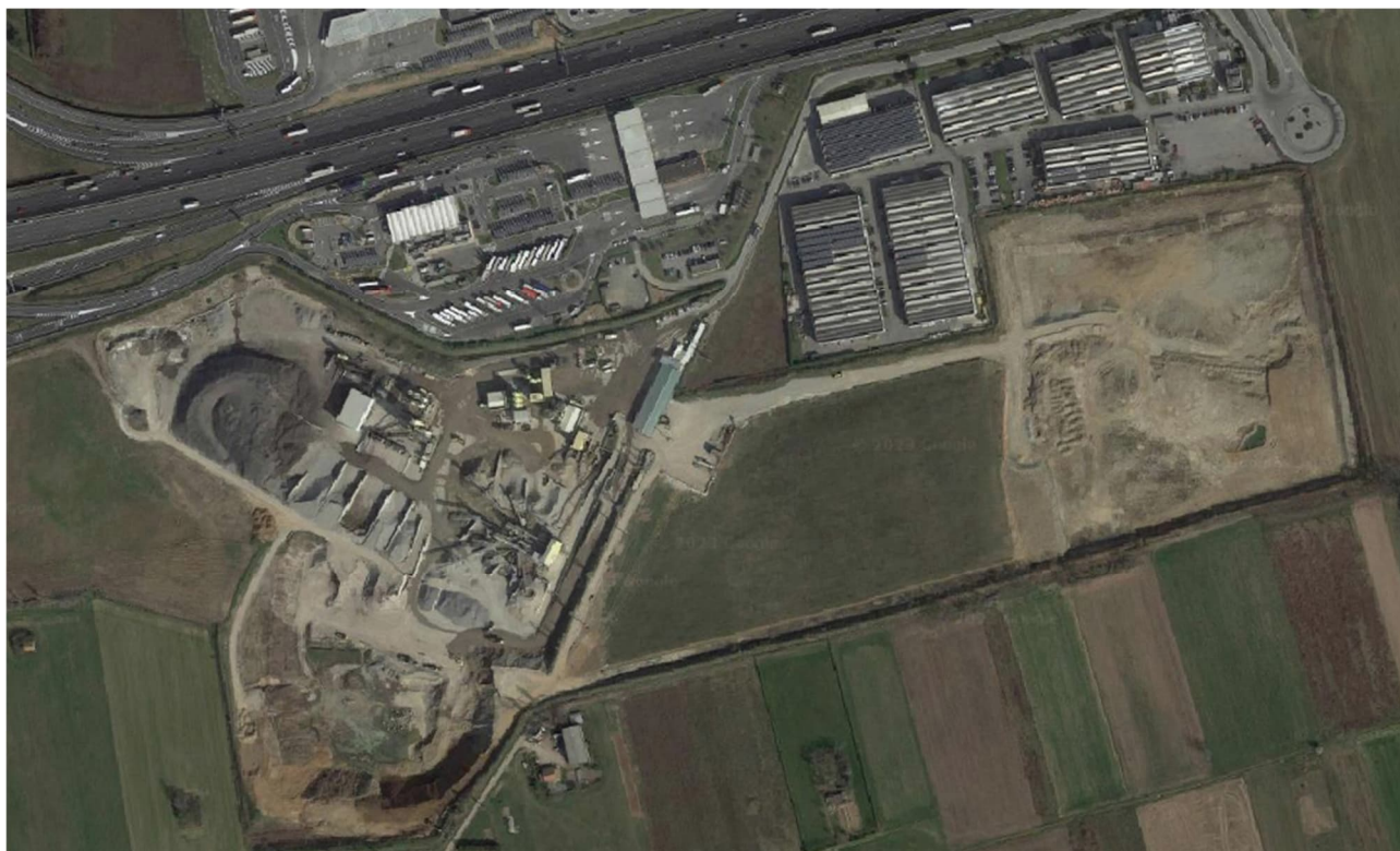
Figura 6-4 – Ortofoto dell'impianto e dell'area di cava di Caponago
