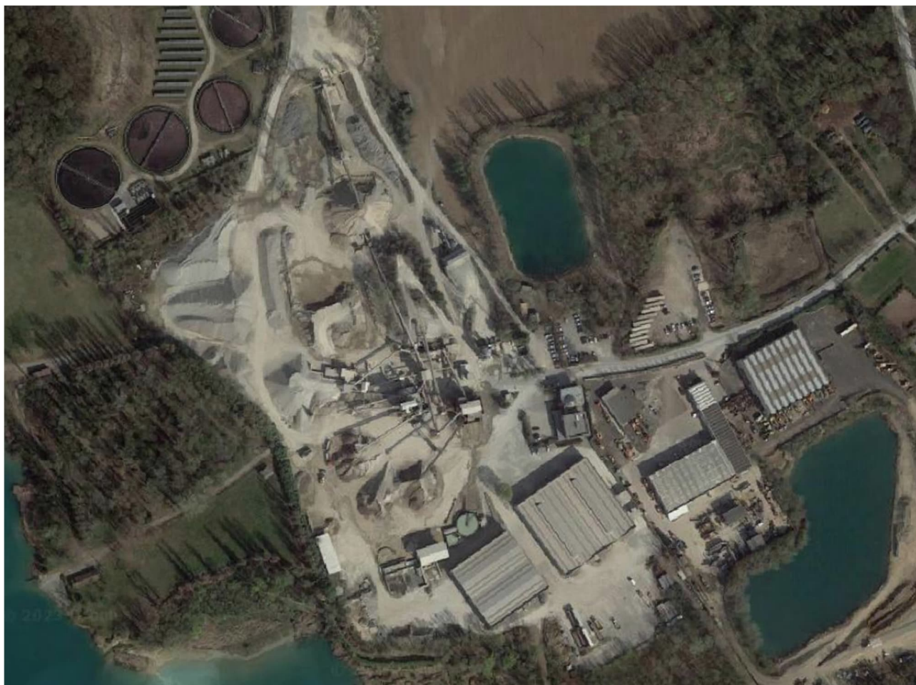
Figura 6-23 – Ortofoto dell'impianto di Brembate
