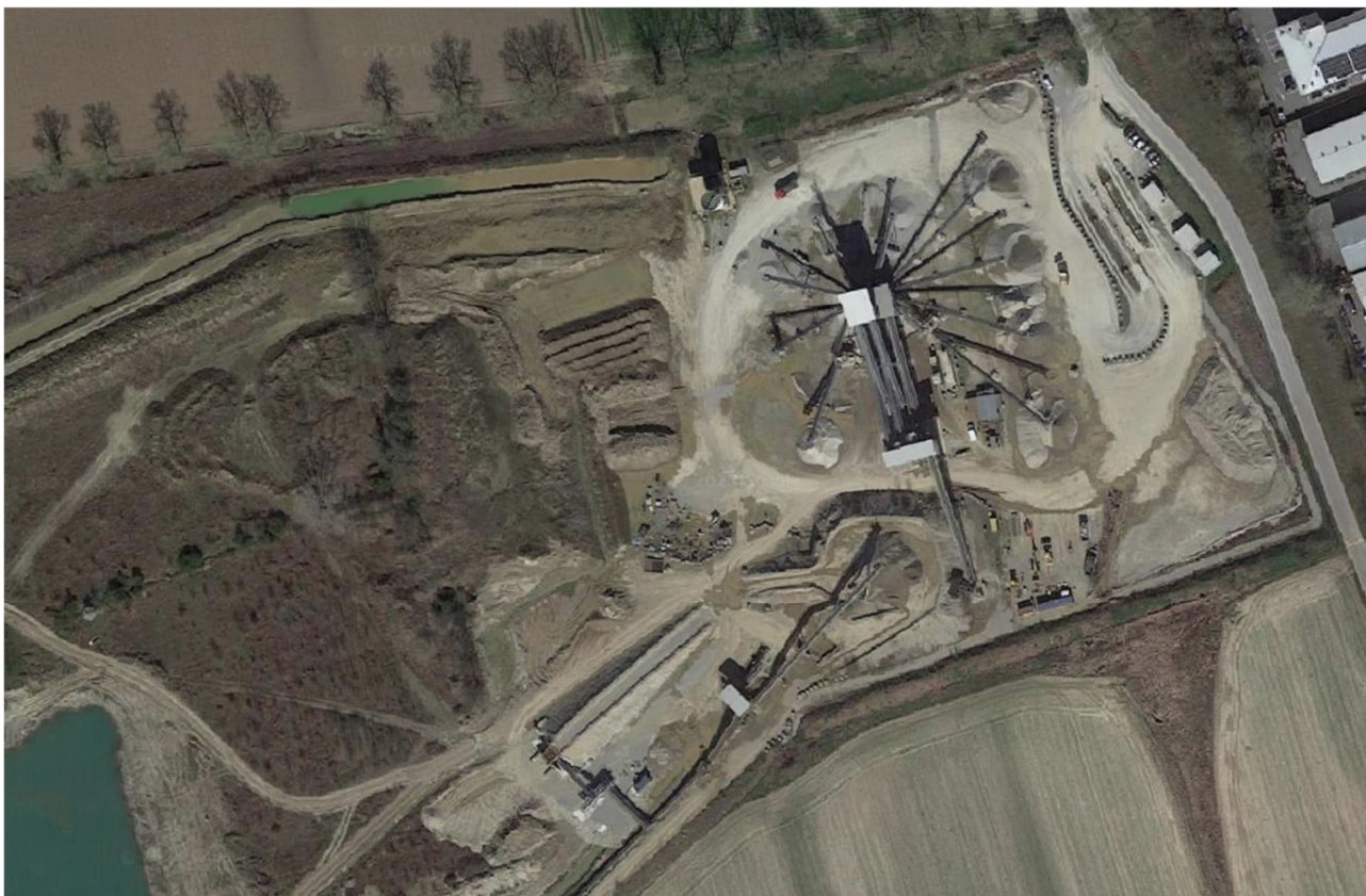
Figura 5-18 – Ortofoto dell'impianto di Pioltello
