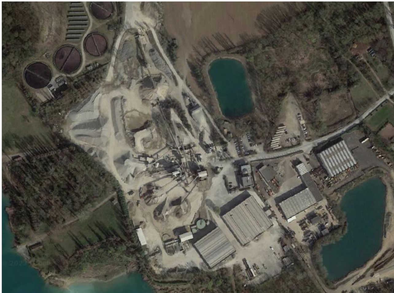
Figura 6-23 – Ortofoto dell'impianto di Brembate
