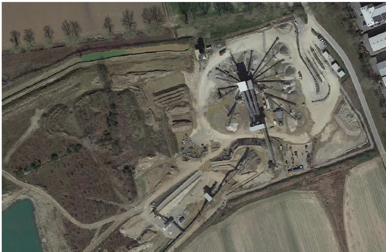
Figura 6-21 – Ortofoto dell'impianto di Pioltello
