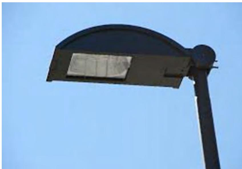
*Figura 4.50: Esempio di apparecchio completamente schermato (full cut-off)*
