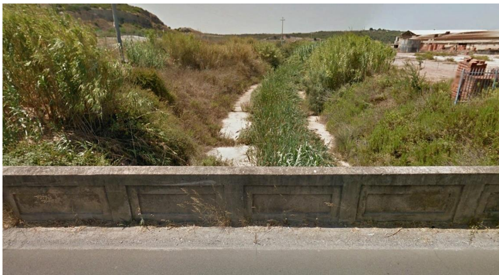
Figura 6.14: Immagine dell'interferenza della connessione con il Riu Flumentepido, vista verso valle.
