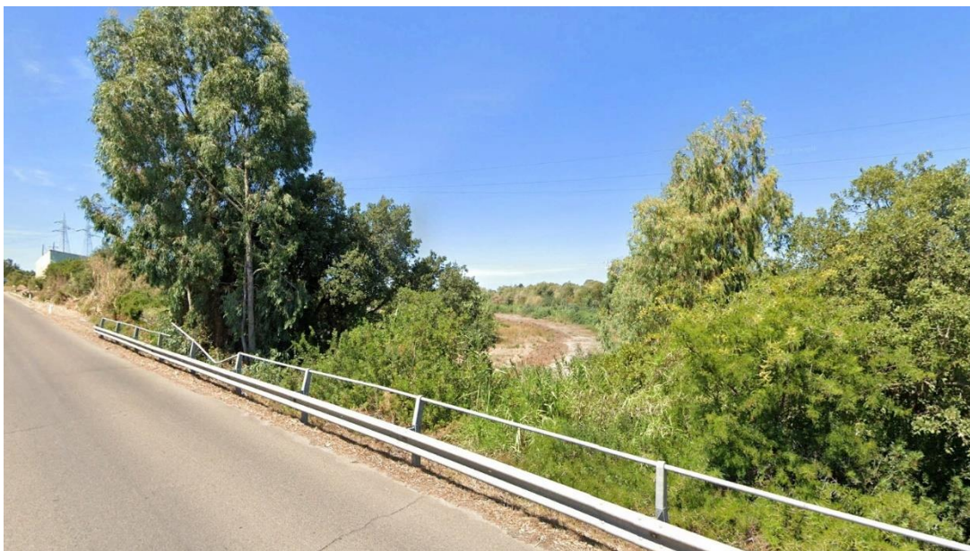
Figura 6.44: Immagine dell'interferenza della connessione con l'elemento idrico Riu Pescinas, vista verso monte.
