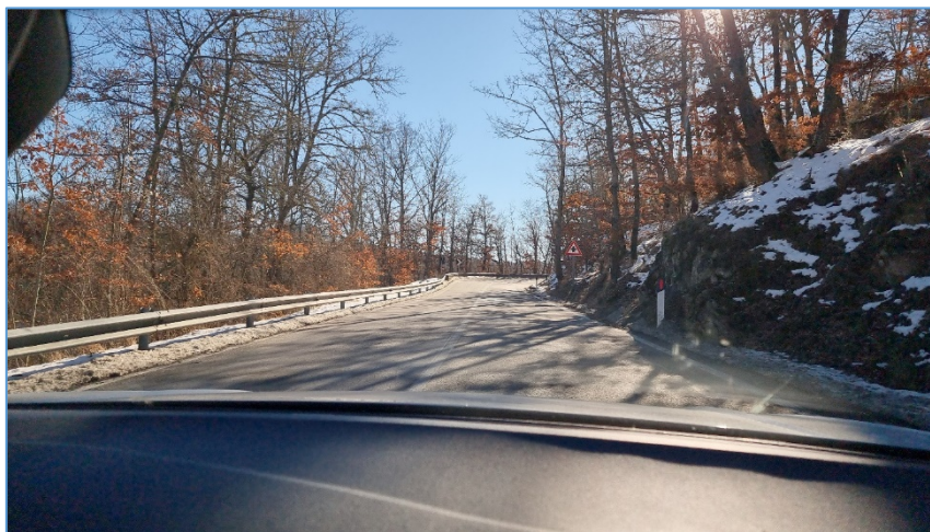
Figura 18 – Tornante tra le progressive di progetto pK1+250 e 1+400
