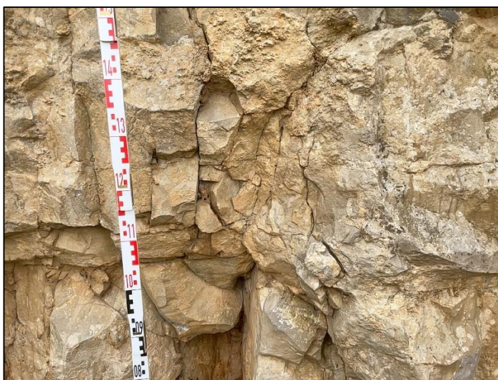
Rilievo geomeccanico ZONA 1
