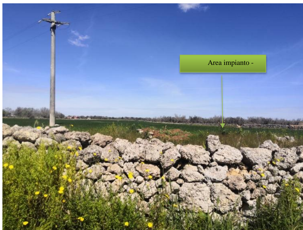
Figura 60: Visibilità impianto dal punto di osservazione 3 – S.P.140 nella direzione del lotto 1
