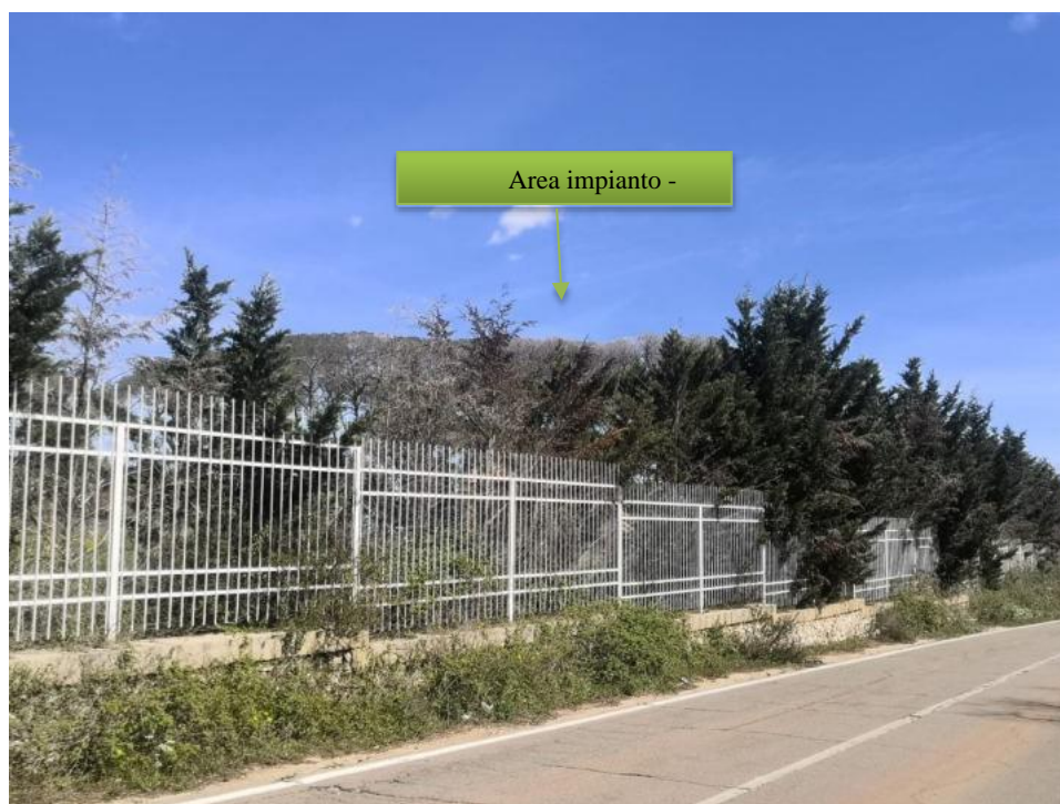
Figura 63: Visibilità impianto dal punto di osservazione 4 – S.P.140 nella direzione del lotto 1
