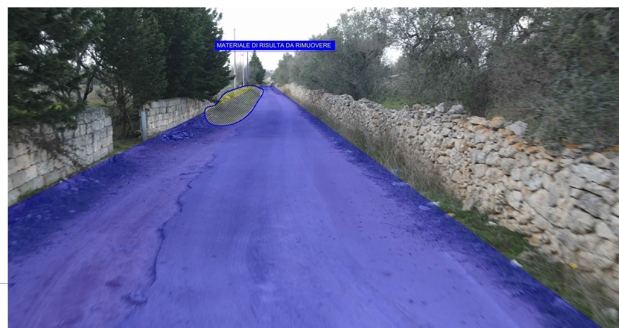
TRATTO DA CONSOLIDARE CON RIPRISTINO DEL CONGLOMERATO BITUMINOSO - RILIEVO 10.11.2022
