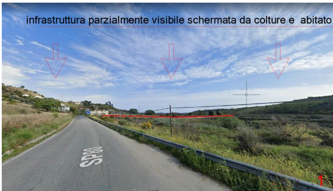
Fig. 6 Ripresa fotografica dello svincolo sulla Variante della SS 106 da nord, dalla SP 80, l'infrastruttura già esistente si vede parzialmente (tratto rosso continuo).
