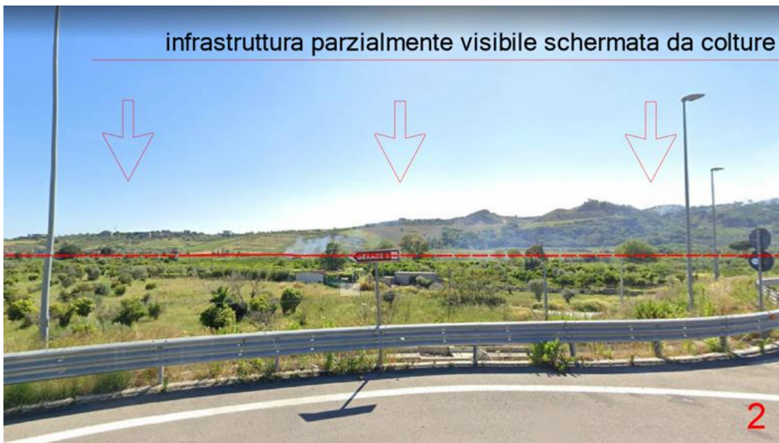
Fig. 7 Ripresa fotografica dallo svincolo sulla Variante della SS 106, l'infrastruttura è parzialmente visibile nella valle della fumara dove insiste su terreni non alberati (tratto rosso continuo).
