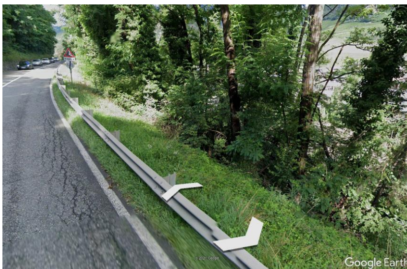
Fig. 3 – Barriera su arginello esistente (sostituito con nuova fondazione e barriera integrata)
