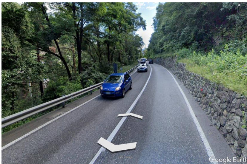
Fig. 2 – Muro con barriera esistente (demolito il cordolo e sostituito con nuova fondazione e barriera integrata)
