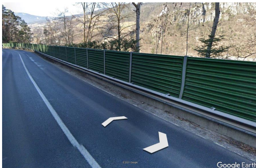
Fig. 1 –Barriera antirumore esistente nel tratto con altezza 2,5 m e 2,0 m
