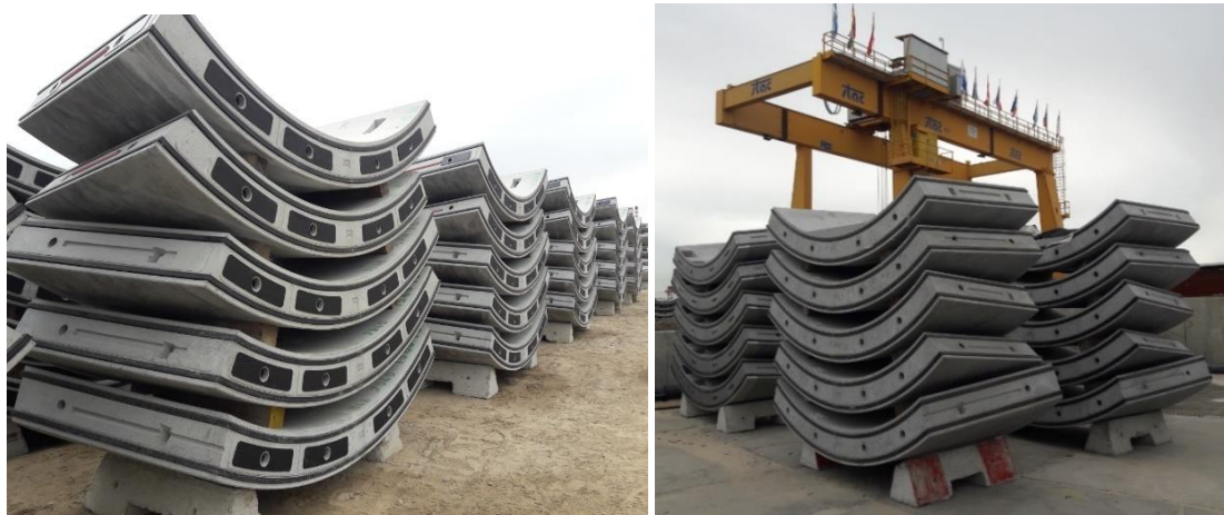
Figura 8-19: Esempio di stoccaggio in cantiere
