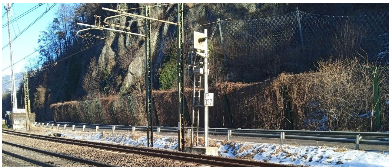
Figure 5-7 – Documentazione fotografica a comprova della presenza di manufatti e opere d'arte nell'intorno della viabilità esistente (nello specifico: sul ciglio di monte si notano a ridosso della strada le barriere paramassi; sul ciglio di valle i presidi ferroviari a ridosso della barriera di sicurezza stradale esistente)
