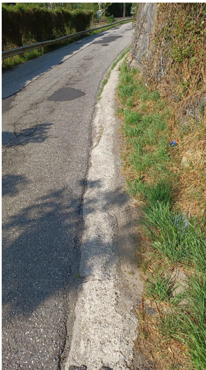
Figure 5-6 – Documentazione fotografica a comprova della presenza di manufatti e opere d'arte nell'intorno della viabilità esistente (nello specifico: sul ciglio di monte si nota il bauletto rinforzato a protezione della fognatura nel tratto dove questa risulta più superficiale: tale presidio si trova a ridosso del piano viabile, ad una quota saltuariamente maggiore di quest'ultimo; a valle si evidenzia un intervento corticale sulla scarpata; sul ciglio di valle la paramassi a ridosso della barriera di sicurezza stradale)
