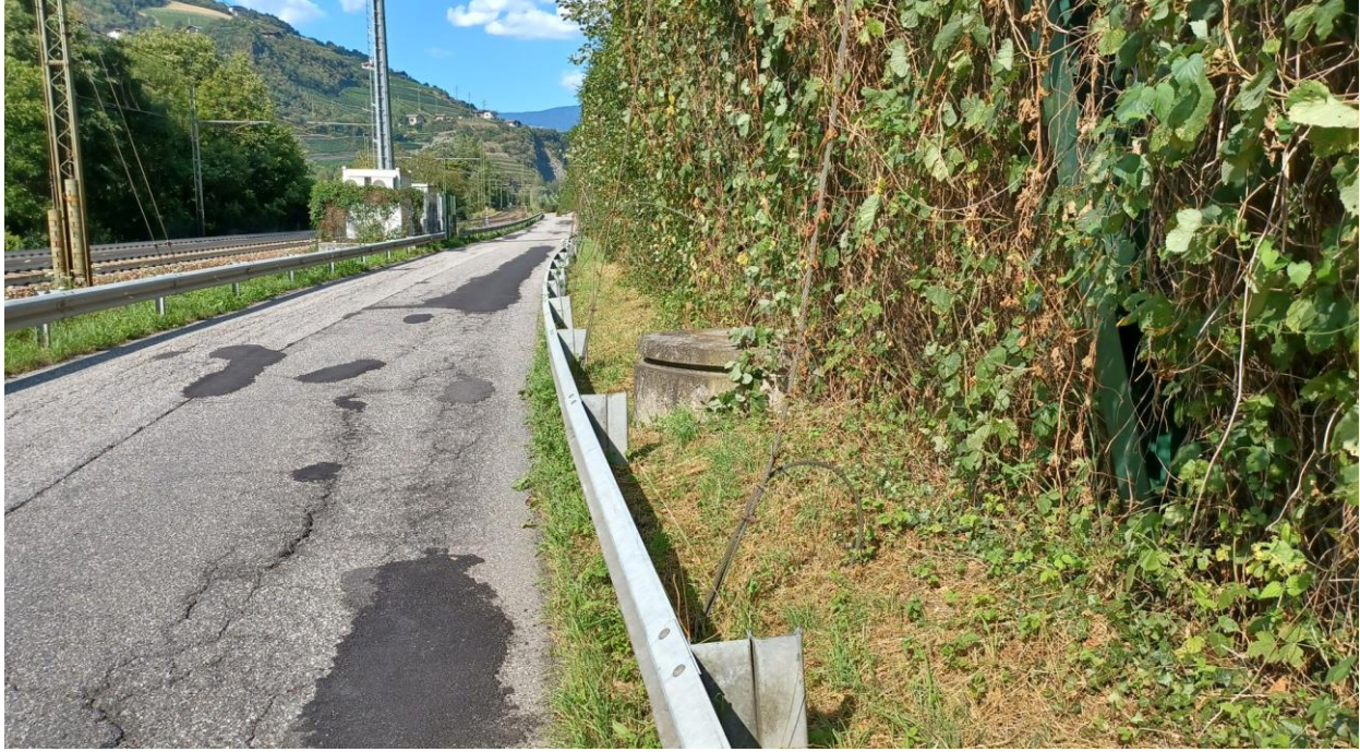
Figure 5-10 – Documentazione fotografica a comprova della presenza di manufatti e opere d'arte nell'intorno della viabilità esistente (nello specifico: sul ciglio di monte si nota la barriera paramassi a ridosso della barriera stradale, oltre ad un pozzetto di ispezione della linea fognaria; sul ciglio di valle i presidi ferroviari a ridosso della barriera di sicurezza stradale esistente)
