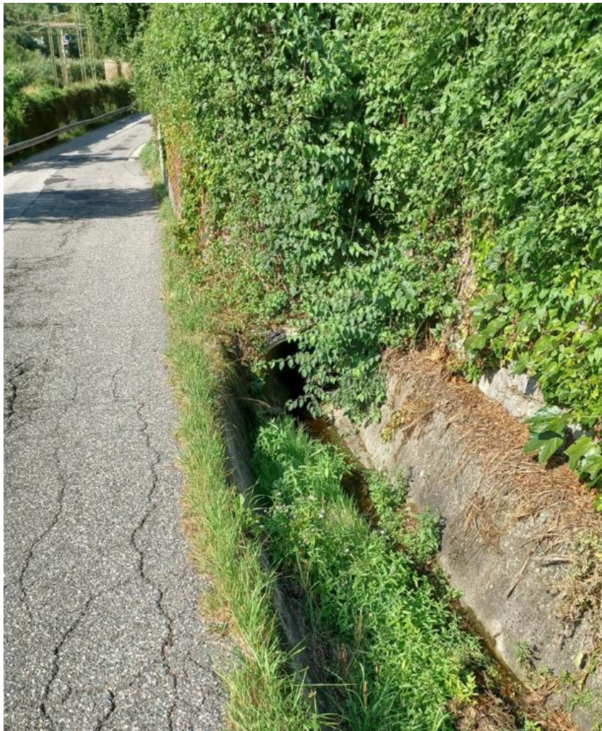
Figure 5-3 – Documentazione fotografica a comprova della presenza di manufatti e opere d'arte nell'intorno della viabilità esistente (nello specifico: sul ciglio di monte si nota il fosso che verrà mantenuto quale presidio del versante; a valle del tombinamento si evidenzia un'opera di sostegno; sul ciglio di valle la barriera paramassi a ridosso della barriera di sicurezza stradale esistente)
