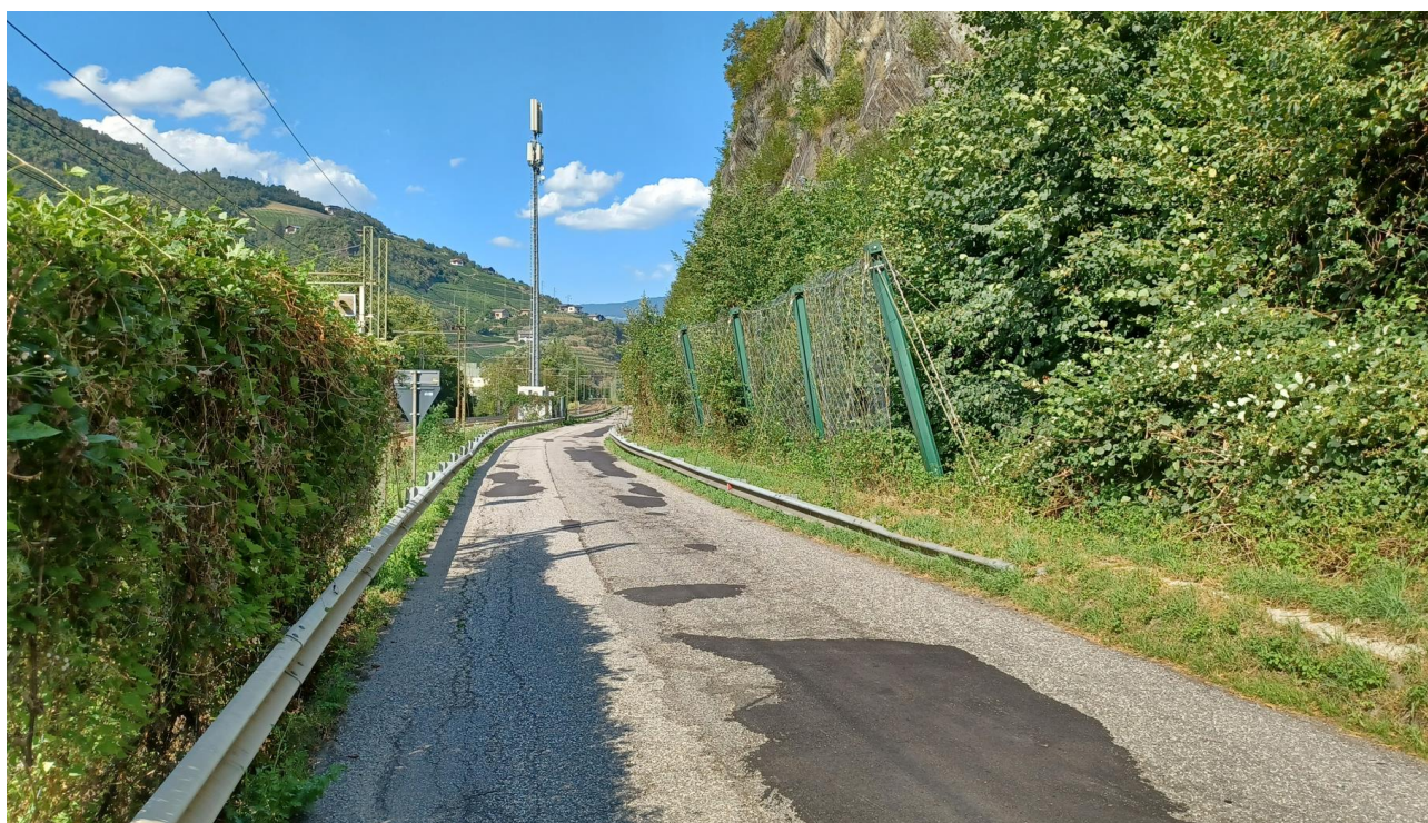
Figure 5-8 – Documentazione fotografica a comprova della presenza di manufatti e opere d'arte nell'intorno della viabilità esistente (nello specifico: sul ciglio di monte si nota la barriera paramassi a ridosso della barriera stradale; sul ciglio di valle una barriera paramassi (ricoperta dalla vegetazione) seguita dai presidi ferroviari a ridosso della barriera di sicurezza stradale esistente)
