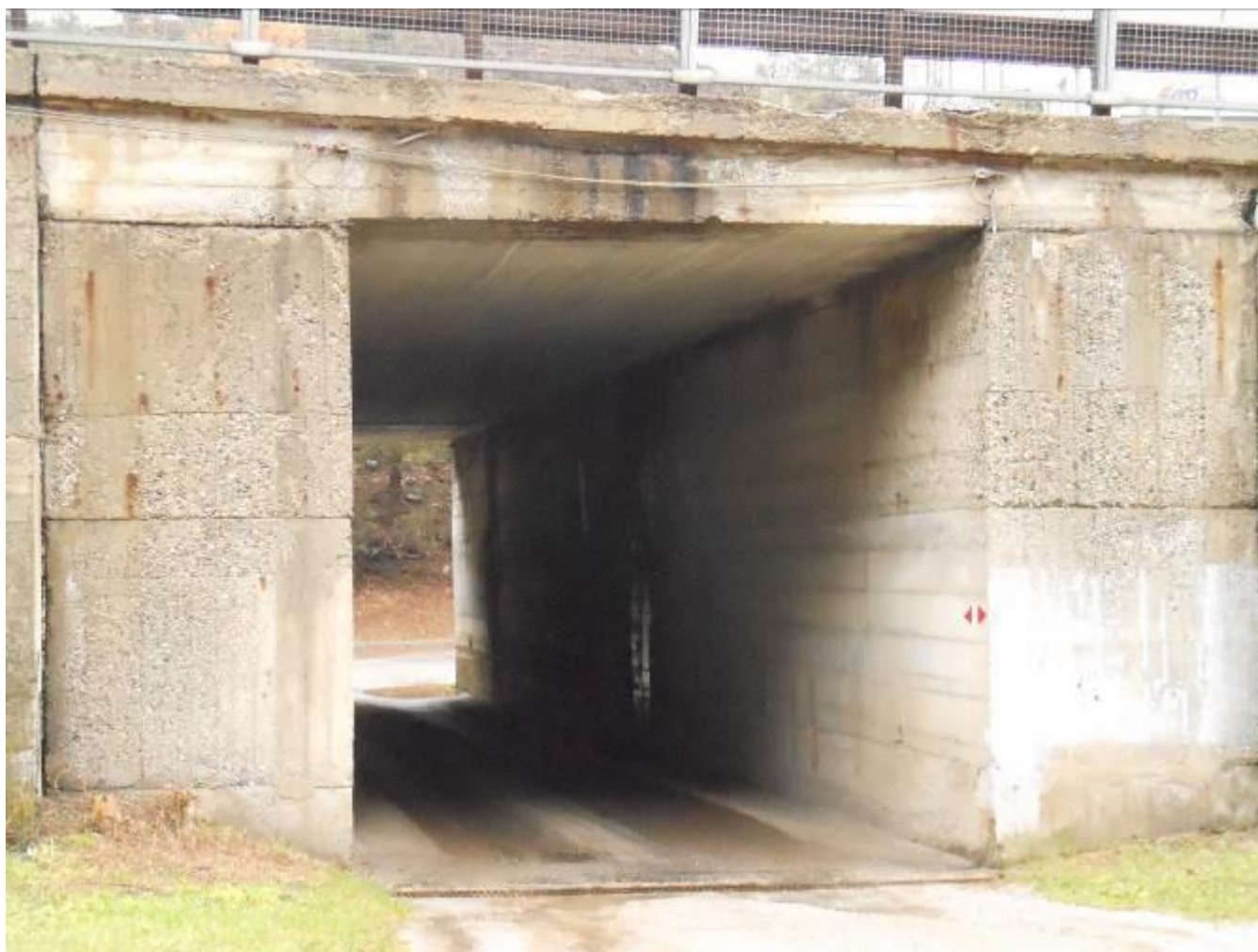
Sottovia esistente per accesso all'area di stoccaggio temporanea A.S.02B
