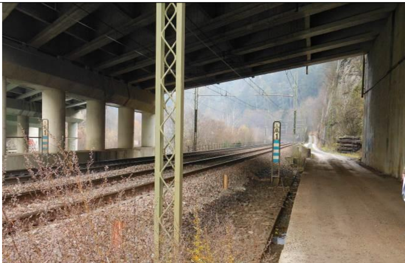
Strada poderale da adeguare per accesso all'area di stoccaggio A.S.03A
