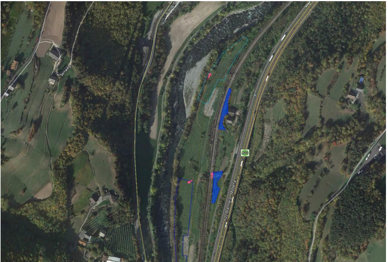
Vista aerea del C.O.06C
