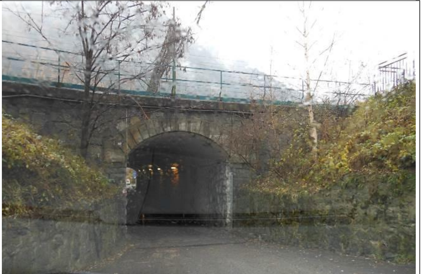
Sottopasso in via Riol esistente
