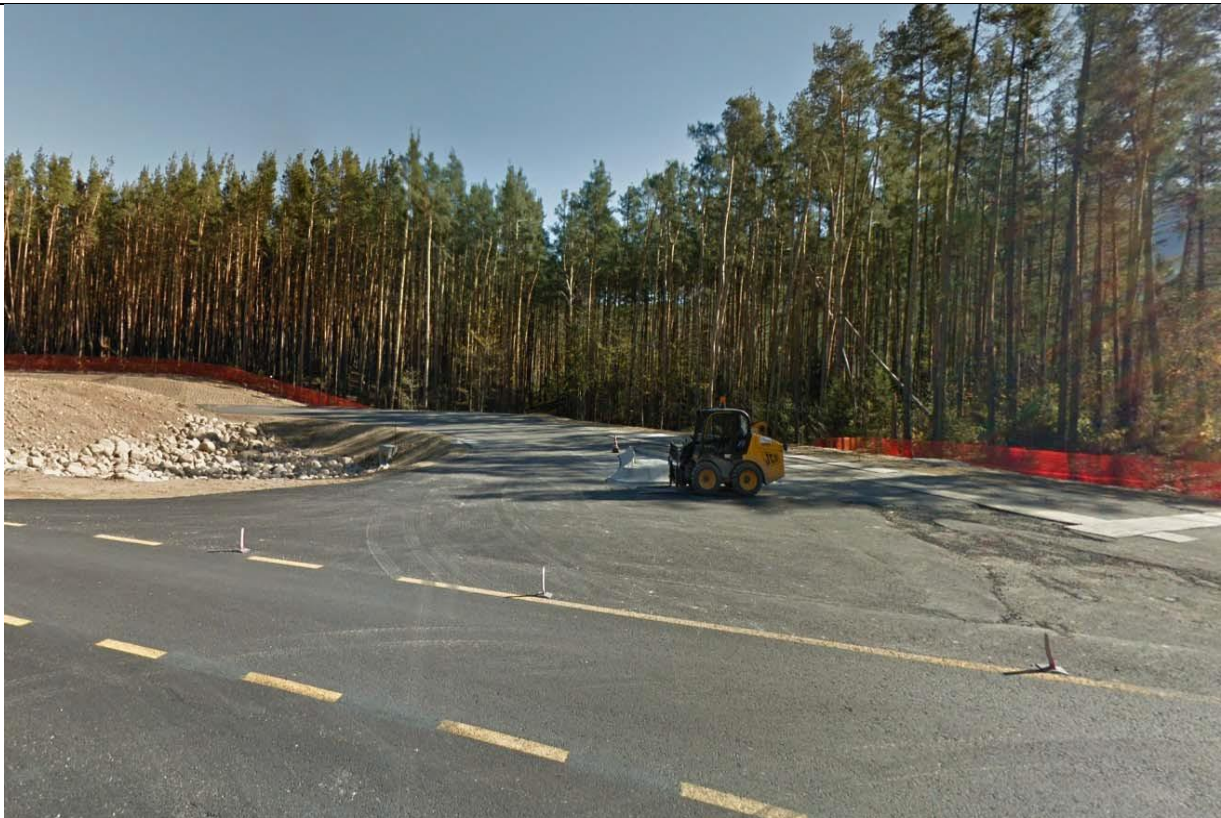
Vista del punto di ingresso, rotatoria, della futura pista di cantiere dalla SS12
