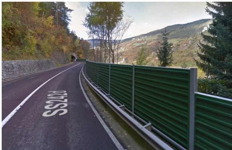
Figura – Barriera antirumore esistente nel tratto con altezza 2,5 m e 2,0 m
