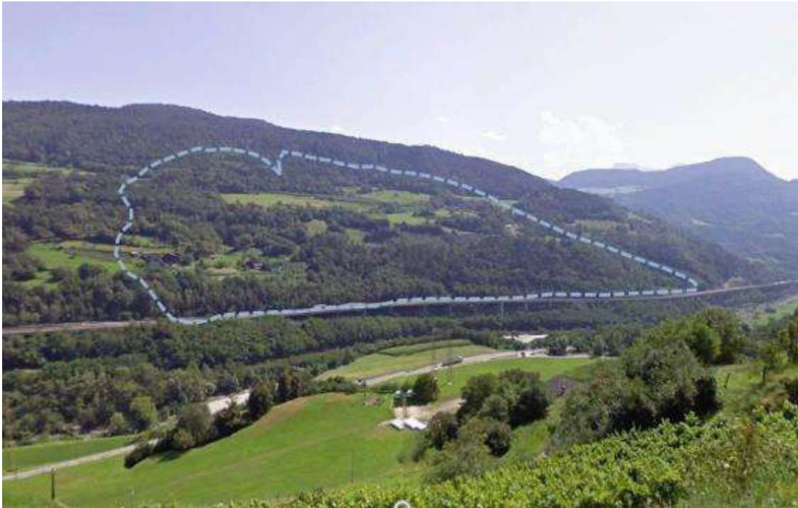
Fig 33: Vista panoramica del versante sinistro della Valle Isarco nel settore della Frana di Ponte Gardena, con evidenziati i limiti del fenomeno gravitativo.
