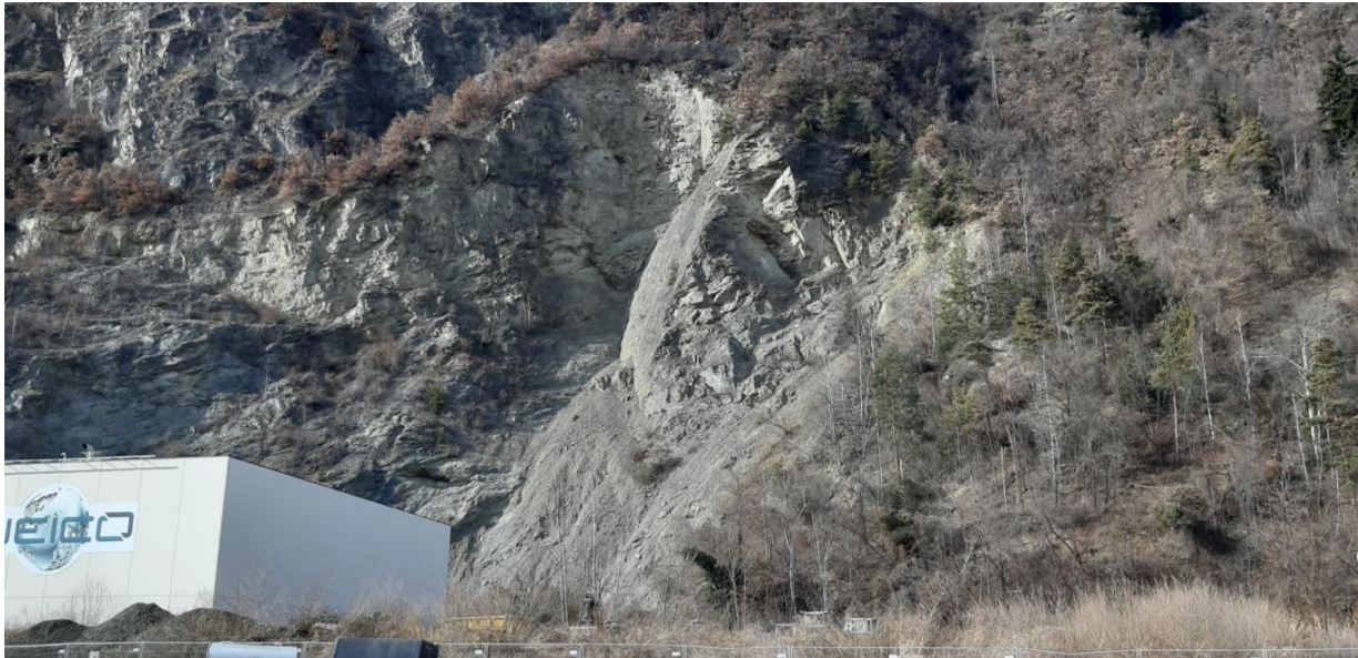
Fig. 38: Panoramica della parete rocciosa ad W dell'imbocco della ex Finestra di Albes, con al centro dell'immagine l'evidente frana di crollo protetta al piede da un vallo in terra rinforzata (sul retro dell'edificio industriale).
