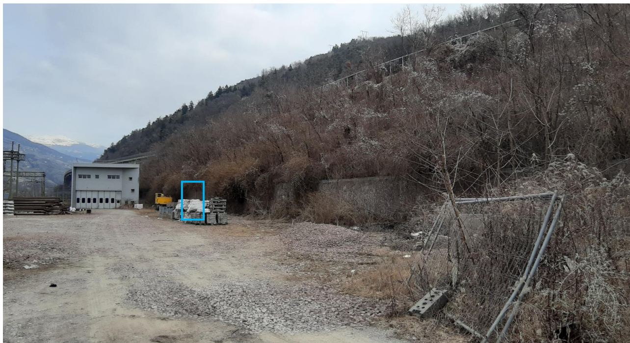
Fig. 111: Vista del muro di sostegno in c.a. presente alla base della scarpata in cui è previsto l'innesto della Galleria di interconnessione – binario pari. Il punto dell'imbocco è evidenziato dal rettangolo azzurro.
