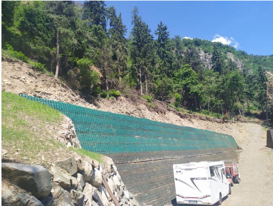
Fig. 40: Vallo di protezione in terra rinforzata lungo lo sbancamento del corpo di frana.
