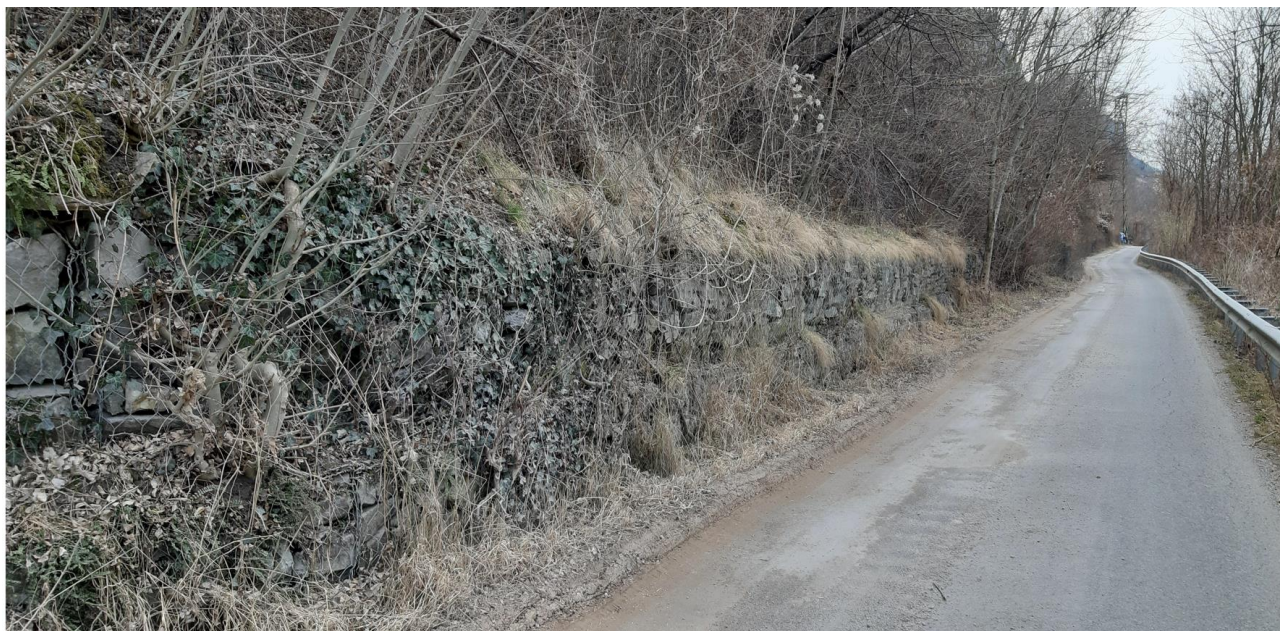
Fig. 113: Gabbionata di pietrame al piede del rilevato autostradale, sul lato di monte della strada comunale.
