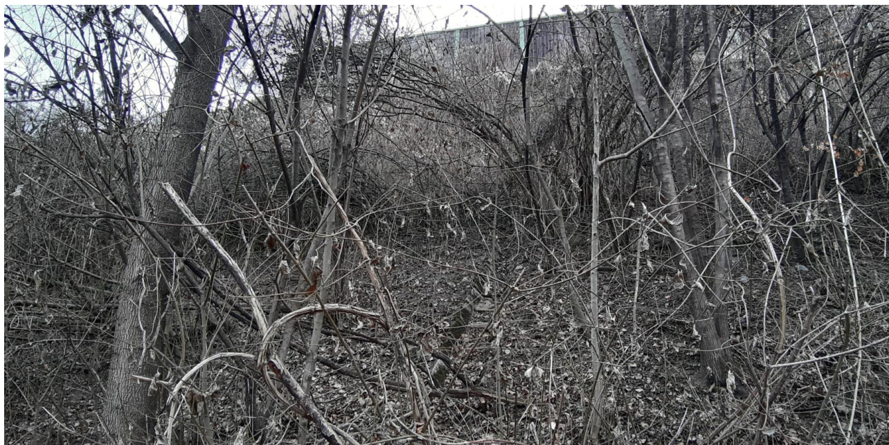
Fig. 112: Parte sommitale del rilevato autostradale realizzata con terra rinforzata (evidenziate entro le due linee tratteggiate gialle). Nella porzione inferiore della scarpata si osservano le canalette trasversali di scolo acque in embrici di cls in buono stato di conservazione.
