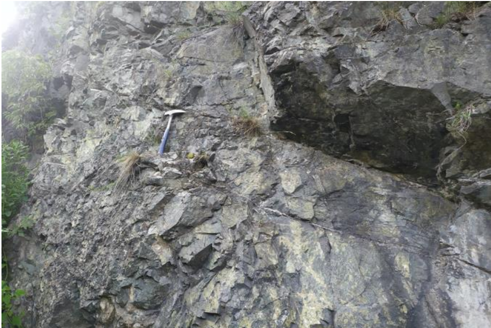
Fig. 84 – Ammasso roccioso di Dioriti di Chiusa in corrispondenza della stazione di rilievo geostrutturale ST-10, eseguita in prossimità dell'imbocco della galleria binario dispari.
