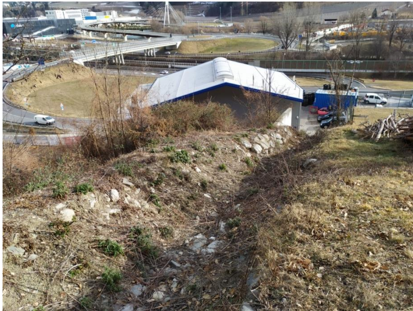
Fig 32: Canale artificiale in corrispondenza della zona di conoide a Sud Ovest di Albes, sulla sinistra si vede il ciglio superiore della scarpata antropica di sbancamento del conoide.
