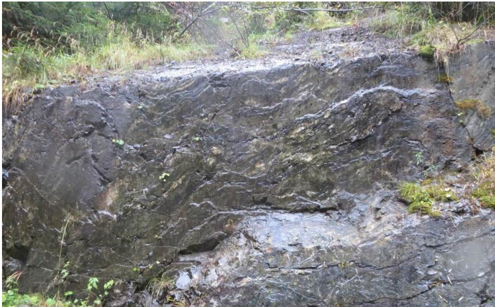
Fig. 25: Cornubianiti da massicce e localmente scistose (MPC), affioramento nei dintorni di Fortezza, lungo il versante a monte dell'imbocco Nord della Galleria Scaleres.
