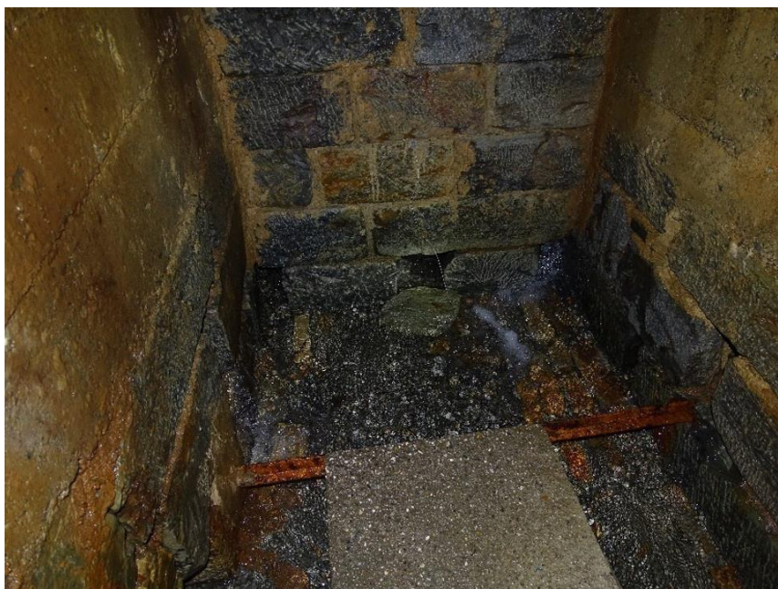
Figura 34: Tunnel di raccolta delle acque della sorgente Gruberwiesen - B_000761.
