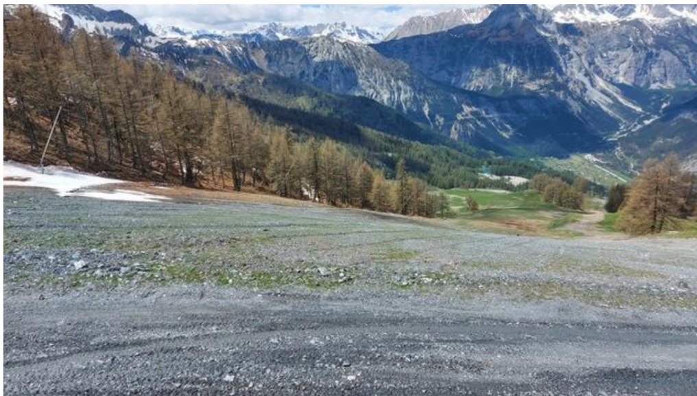
Parte 3 di cantiere – fine inverno 2016
