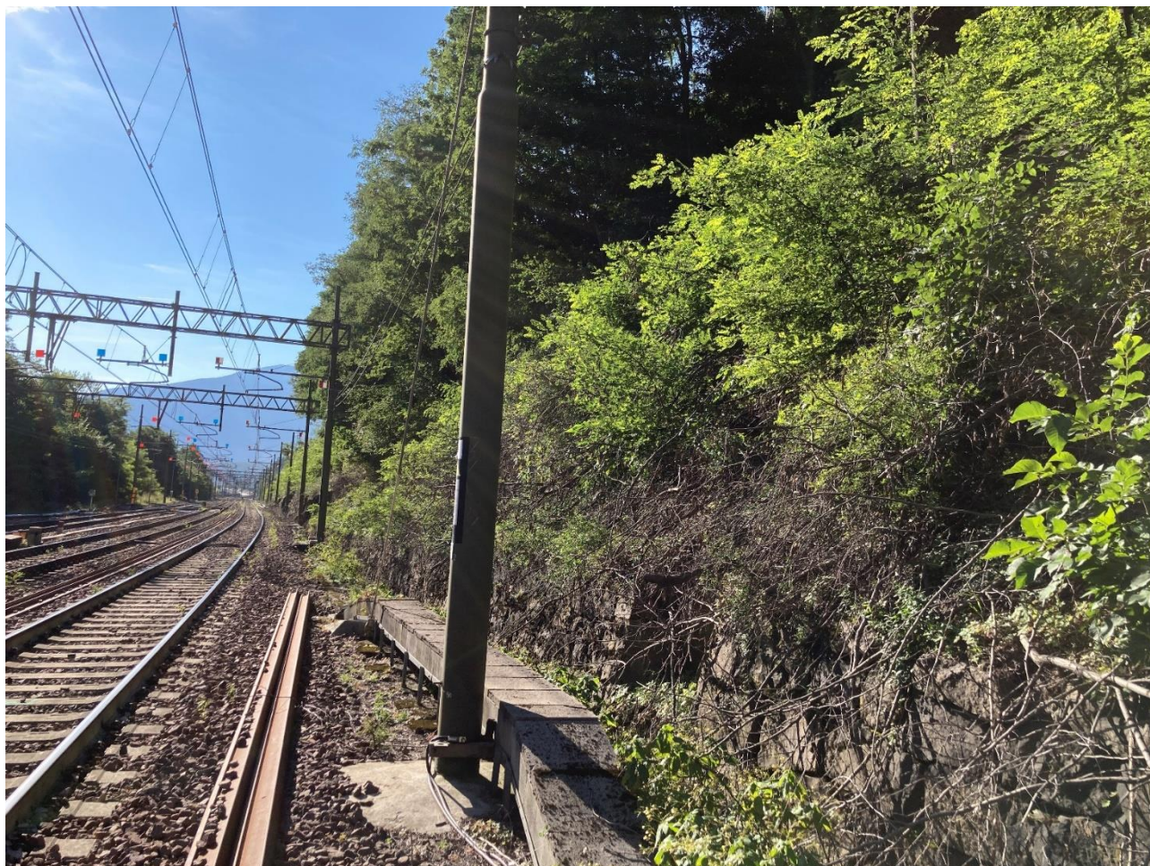
Figura 7-10 – Zona dell'imbocco Nord della Galleria Scaleres
