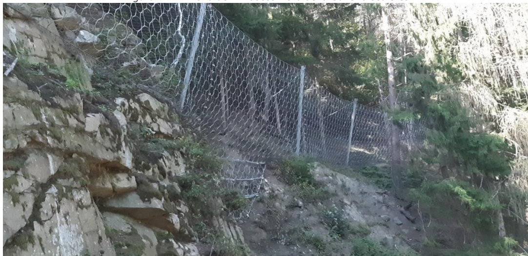
Figura 7-13 – Zona dell'imbocco Nord della Galleria Scaleres
