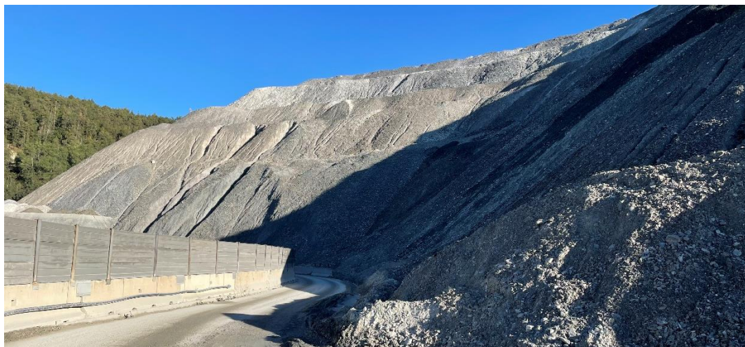
Figura 7-6 – Foto dell'attuale sito di deposito di Hinterrigger
