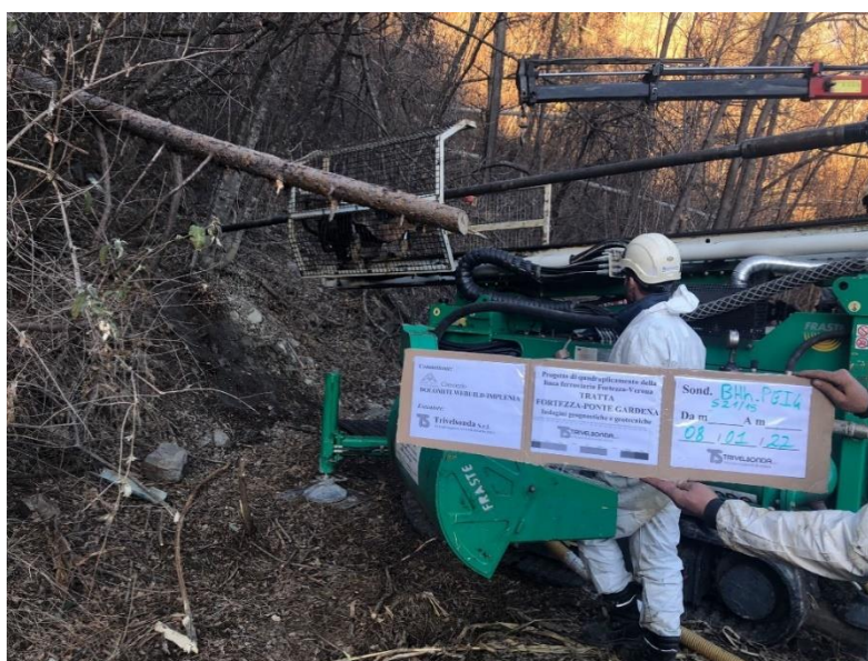
Figura 7-7 – Sondaggio S21/15 nella zona dell'imbocco della finestra di Albes
