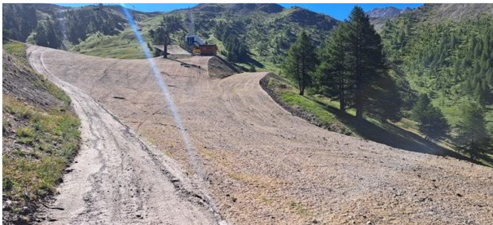
Parte 1 di cantiere - posa inizio estate 2016
