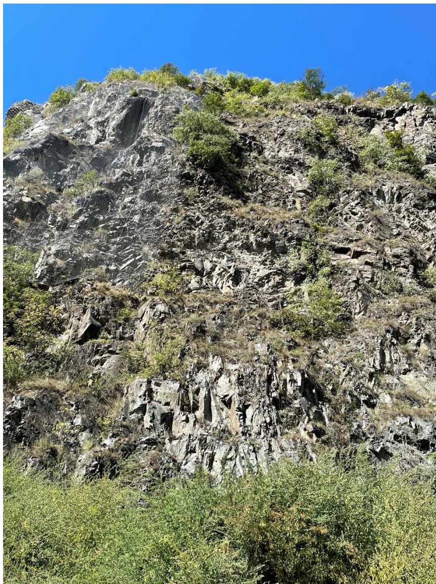
Figura 7-15 – Zona dell'imbocco Sud della Galleria Scaleres
