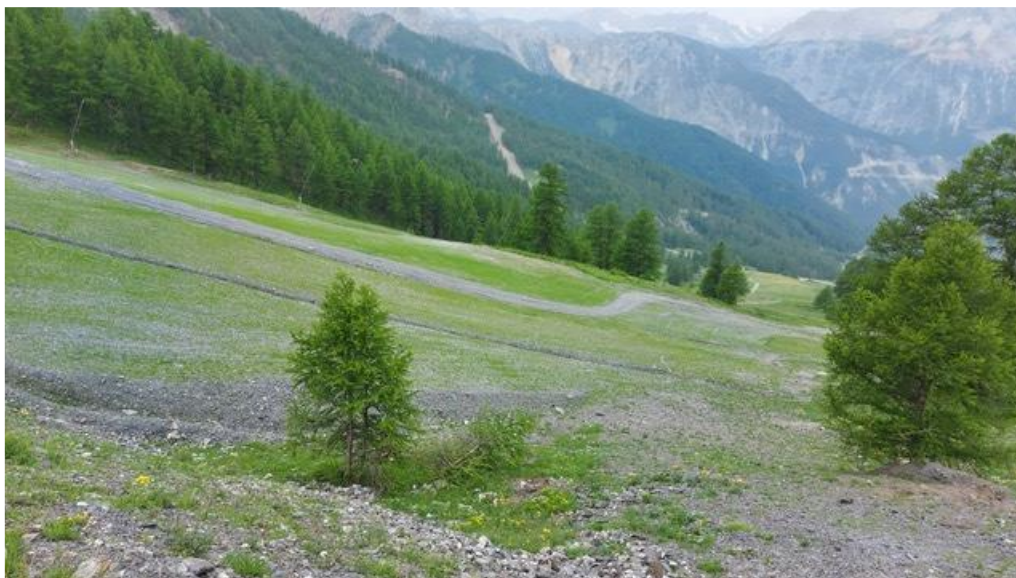
Parte 3 di cantiere – inizio primavera 2016
