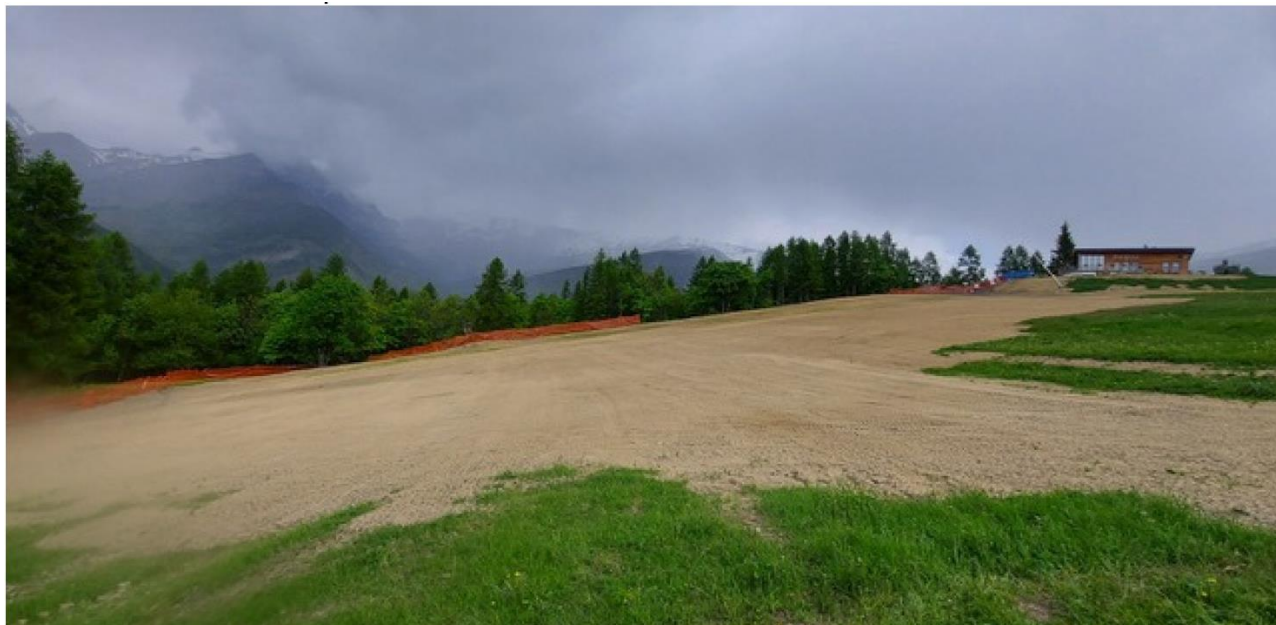
Parte 2 di cantiere - posa inizio estate 2016
