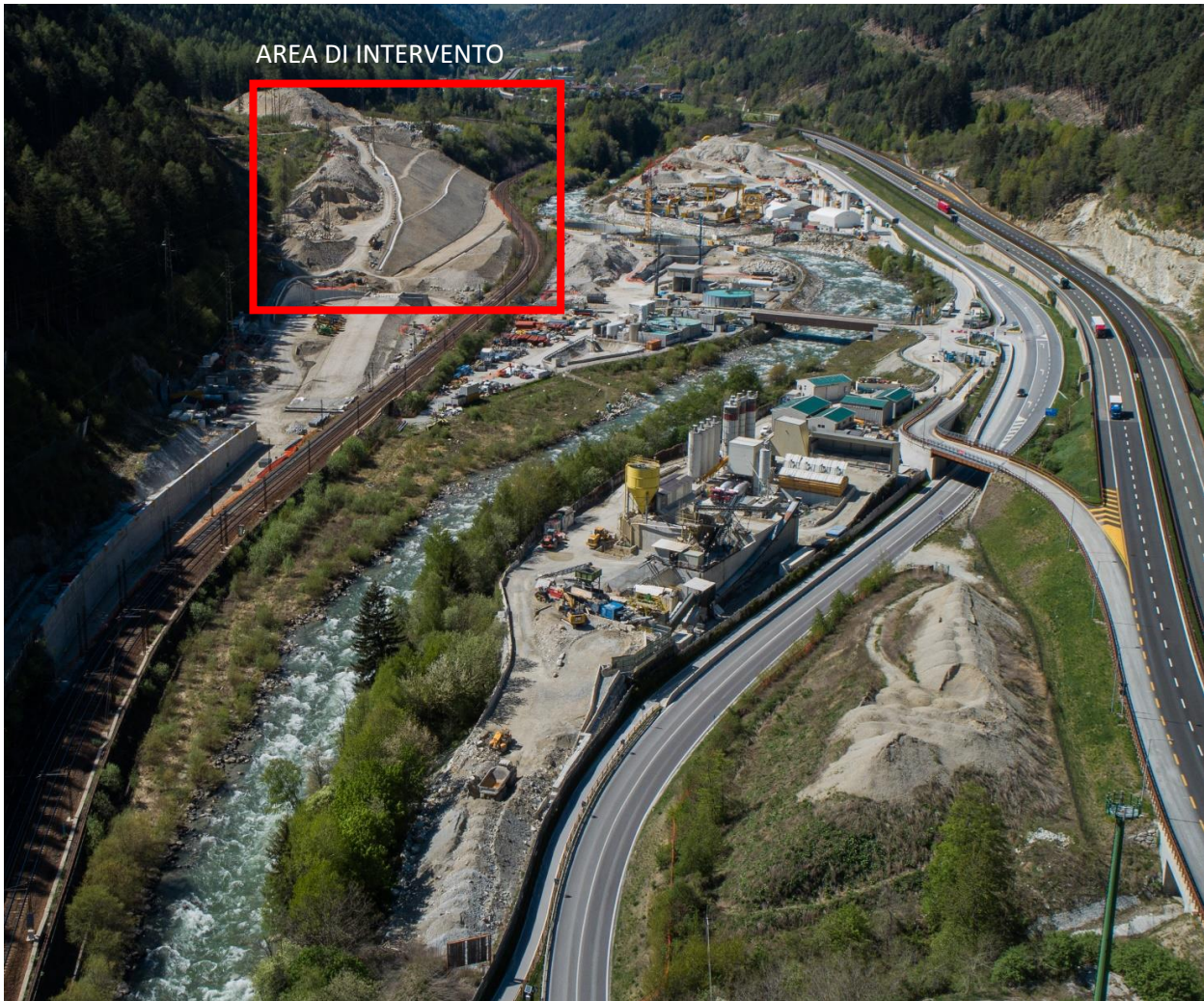
Condizioni ante operam
