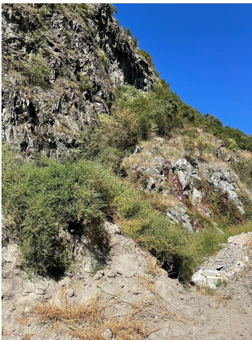
Figura 7-14 – Zona dell'imbocco Sud della Galleria Scaleres
