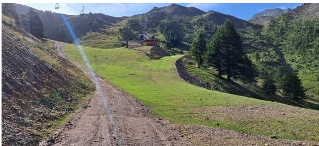
Parte 1 di cantiere – stato dei luoghi fine estate 2016
