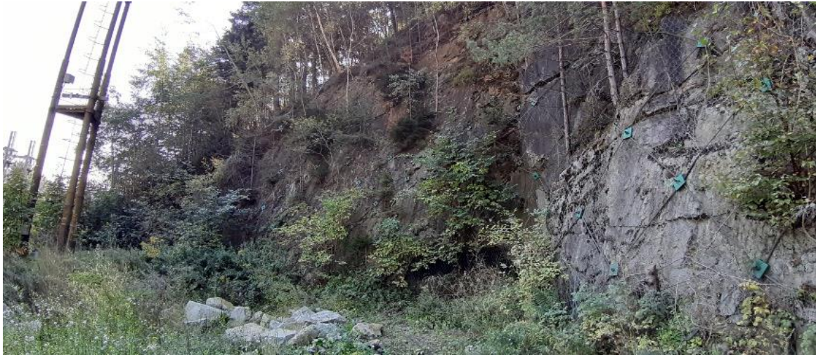
Figura 7-11 – Zona dell'imbocco Nord della Galleria Scaleres
