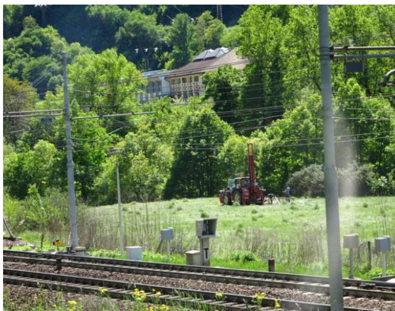
Figura 7-17 – Sondaggio EO24 della zona di Ponte Gardena
