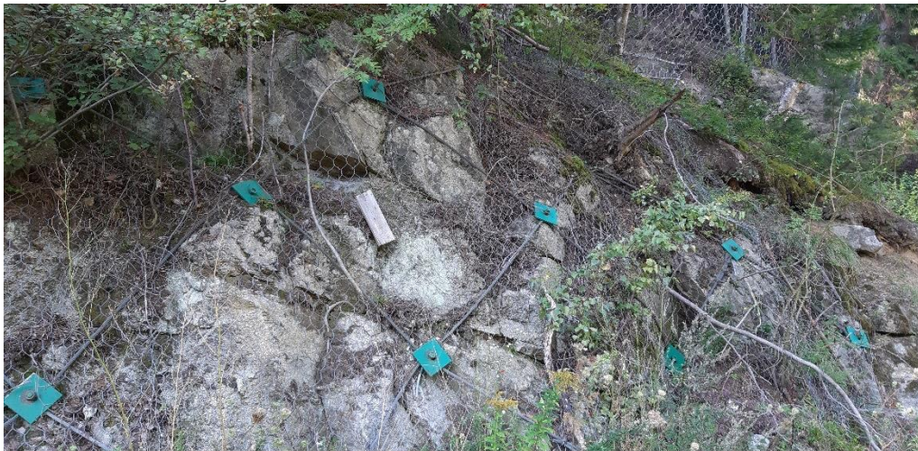
Figura 7-12 – Zona dell'imbocco Nord della Galleria Scaleres
