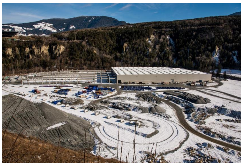
Figura 17-11 Foto dello stato dei luoghi del cantiere BBT
