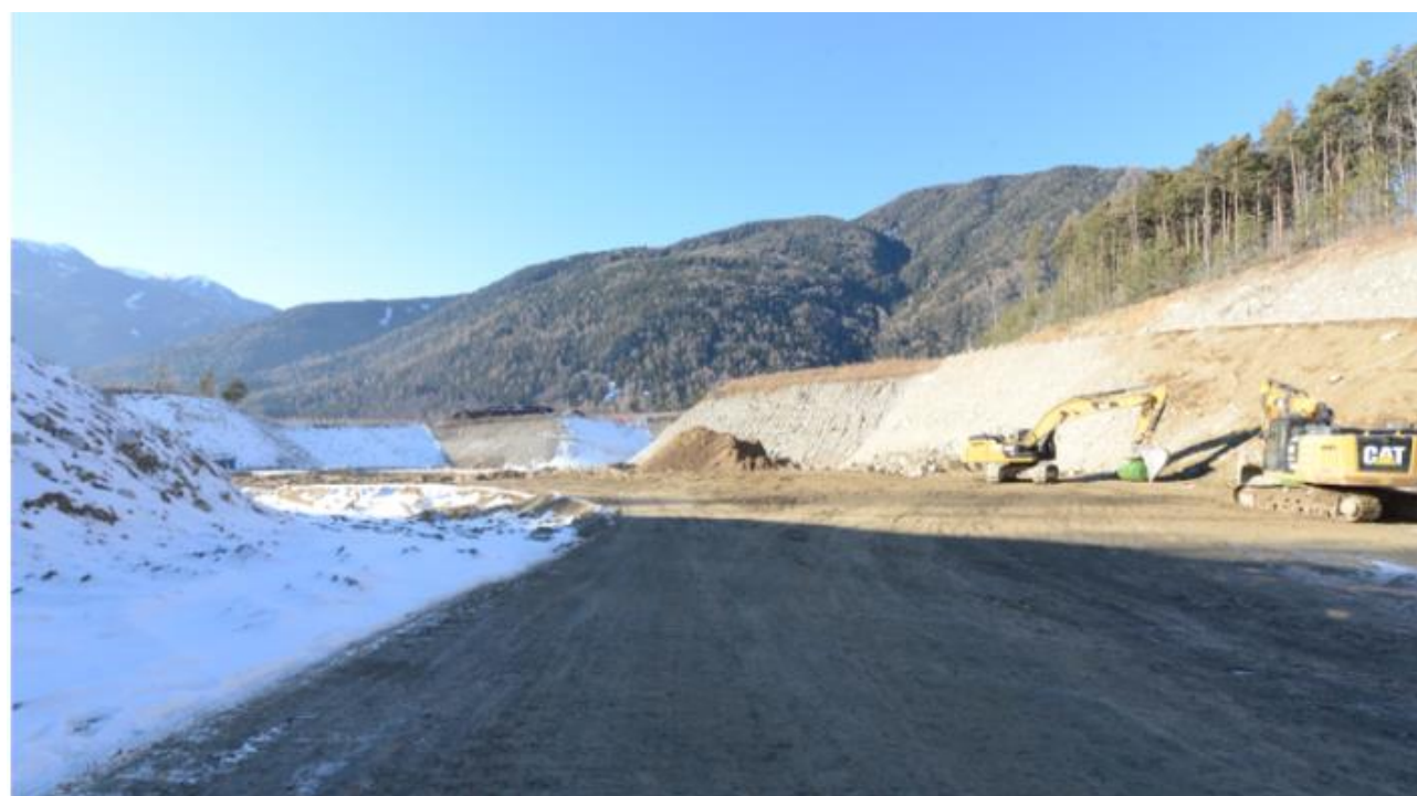
Figura 6-52 - Finestra di Forch - Ante operam
