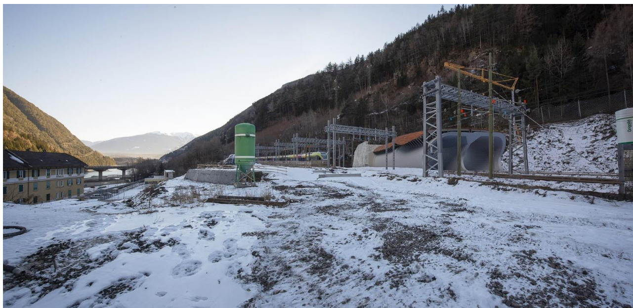
Figura 6-69 – Imbocco Nord Scaleres post operam
