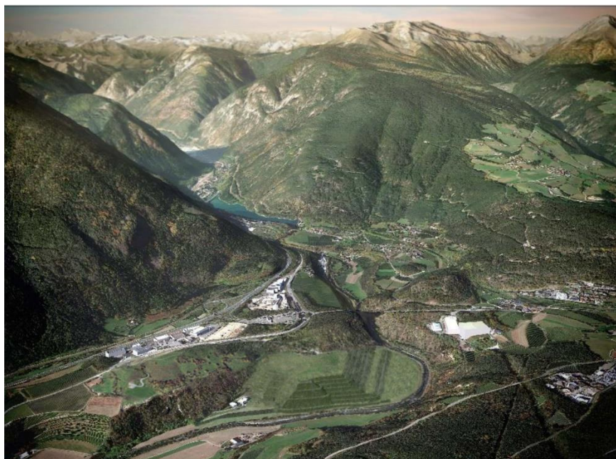
Figura 6-42 Situazione post operam di PE
