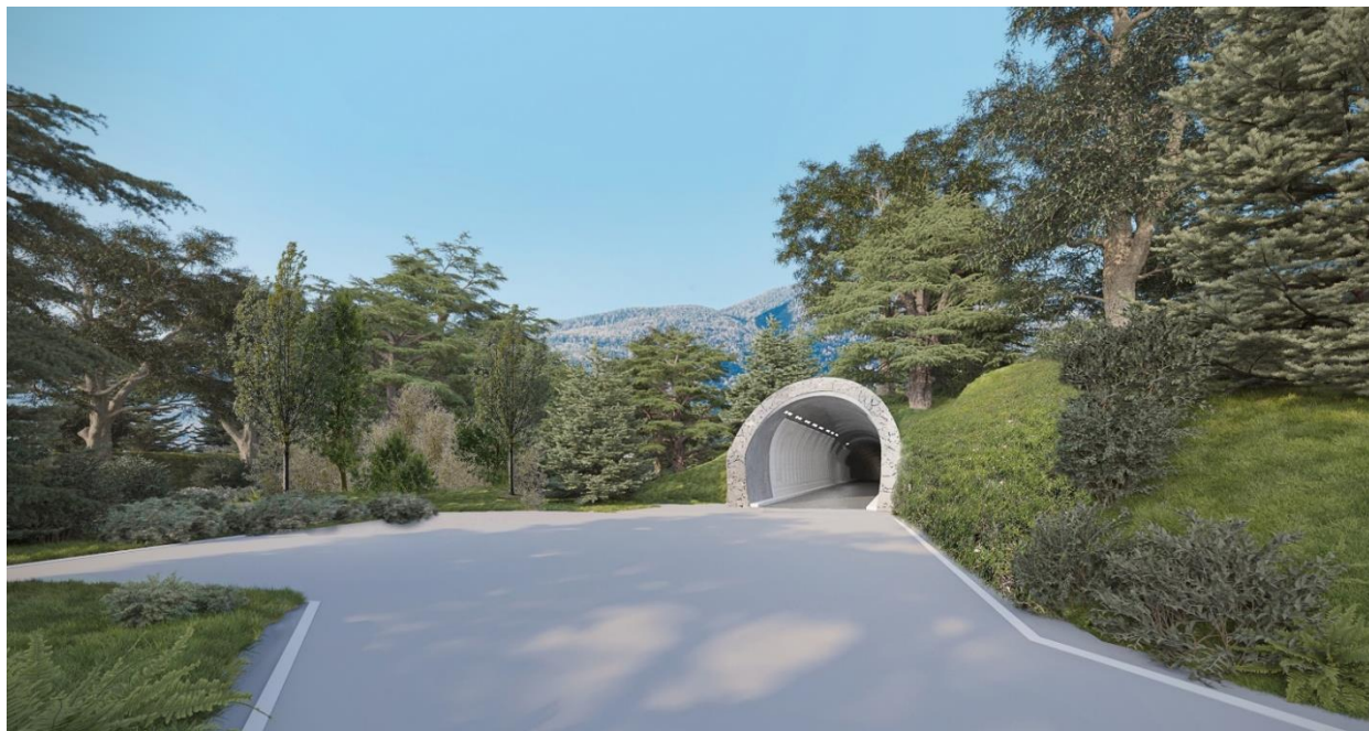
Figura 6-53 - Finestra di Forch - Post operam
