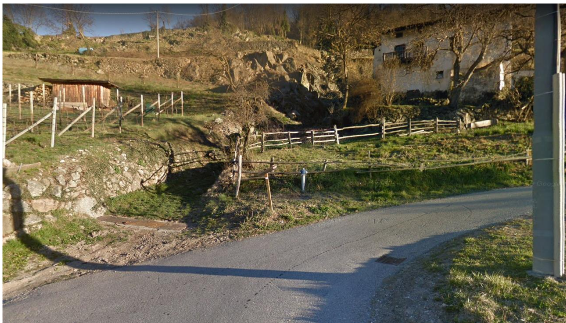
Fig. 10 – Caditoie in prossimità dell'intervento relativo alla sorgente S7A
