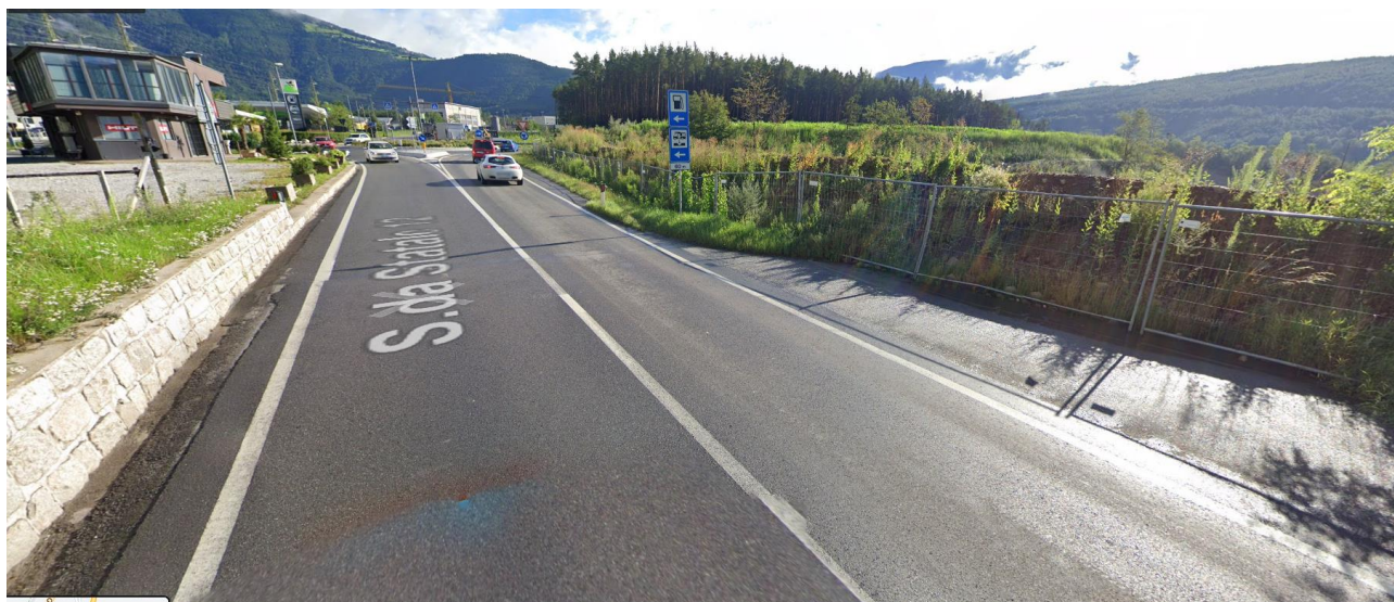
Fig. 2-3 Monitoraggio SS12 Finestra di Forch – vista della strada (fonte Google street view)
