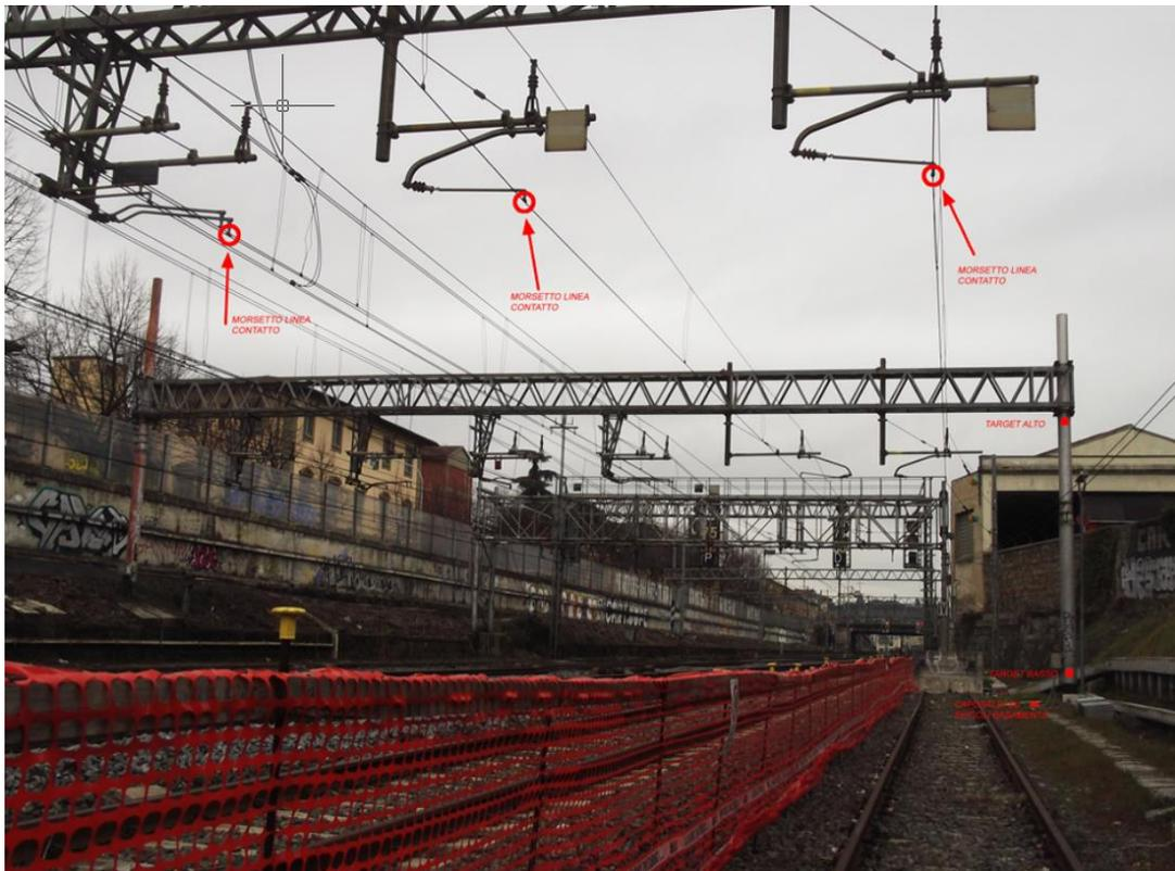
Figura 4 - Punti di installazione della strumentazione sui pali TE
