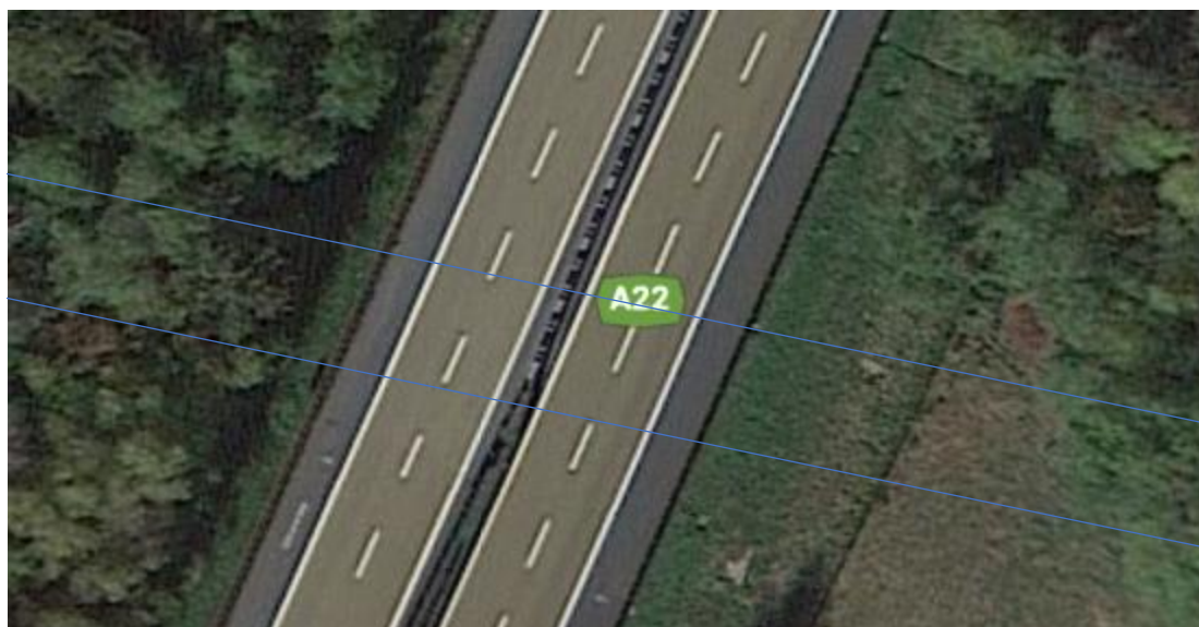
Fig. 12-5 Monitoraggio A22 Finestra di Forch – ortofoto zona in oggetto ( fonte Google Earth)
