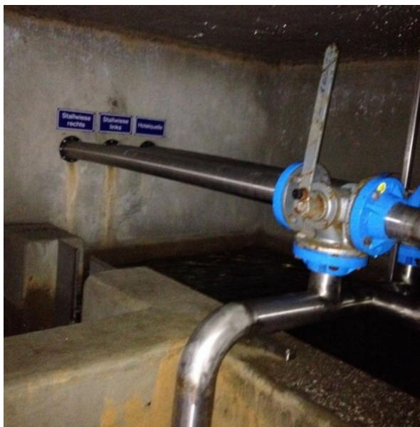
Figura 12: Opera di captazione della sorgente Salern con relativo stramazzo a pareti sottili
