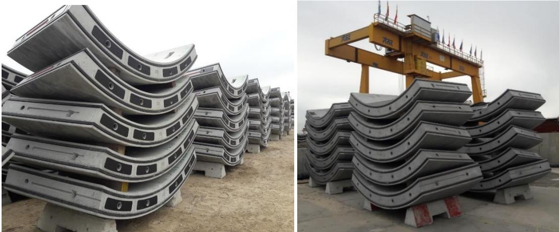
Figura 8-19: Esempio di stoccaggio in cantiere
